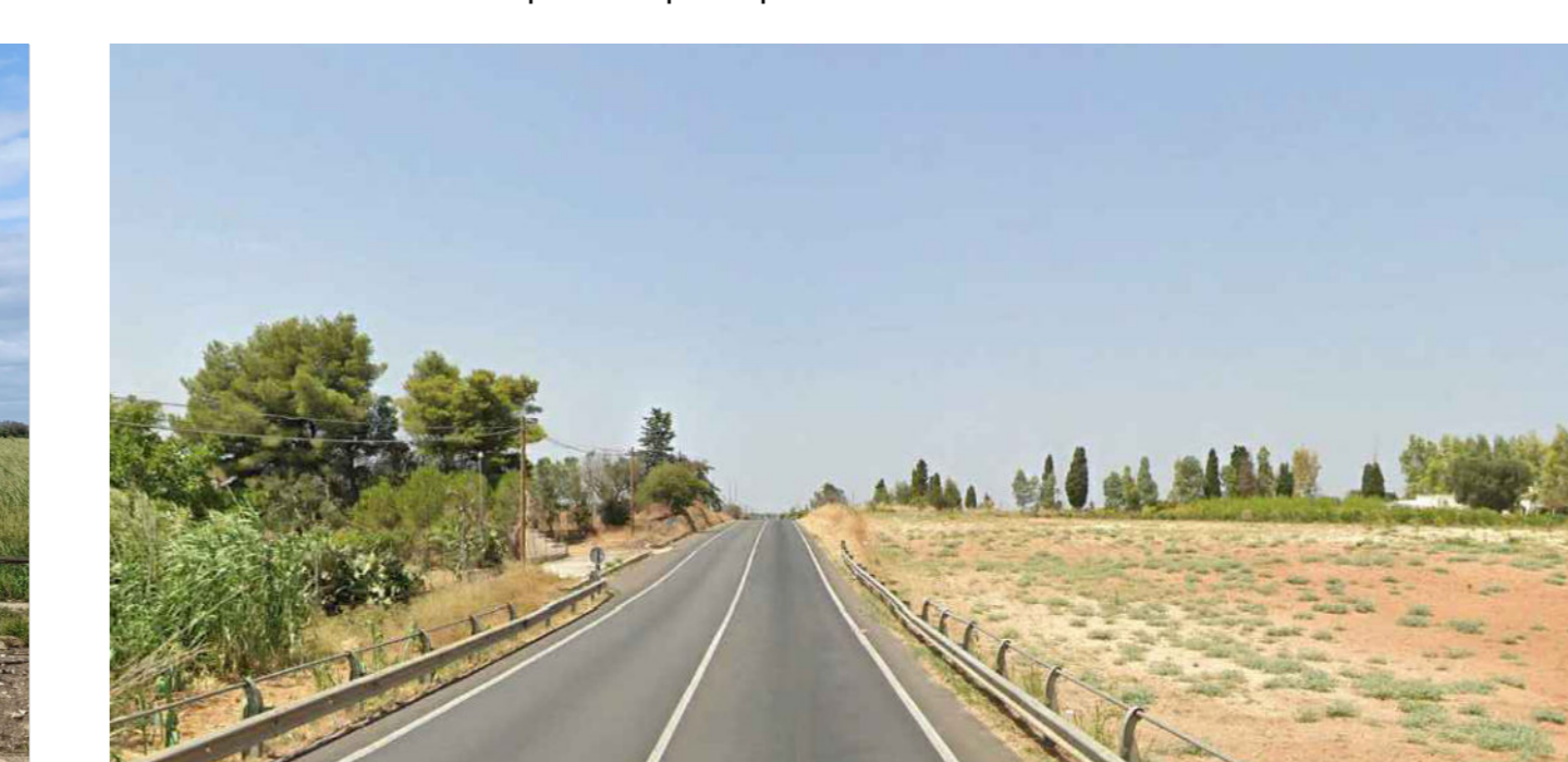
P.O. 300: Masseria mascava - ante operam
