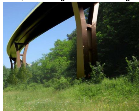
Fig. 38 Sezioni tecniche e render (cfr. relazione tecnico-descrittiva presentata con l'istanza T00EG00GENRE02A ). A sinistra la piattaforma prevista per i tratti curvi di larghezza complessiva pari a m 13.30, sorretta da una trave di altezza minima pari a m 2.80 e la pila in prospetto laterale presenta una misura di 260 cm alla base e 160 all'attacco superiore con le due antenne inclinate. L'altezza dichiarata nella Relazione tecnica è di 25 metri.
