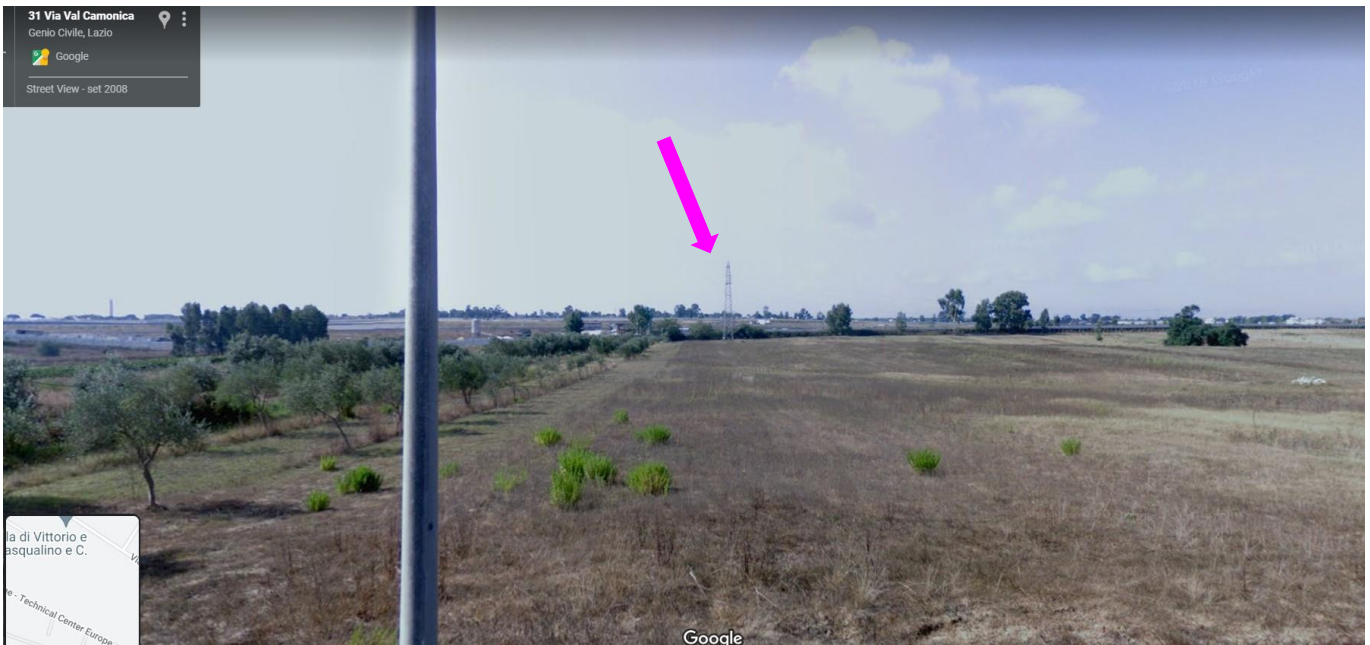
Figura 39 Traliccio da rimuovere P 27 vista da via Val Camonica
