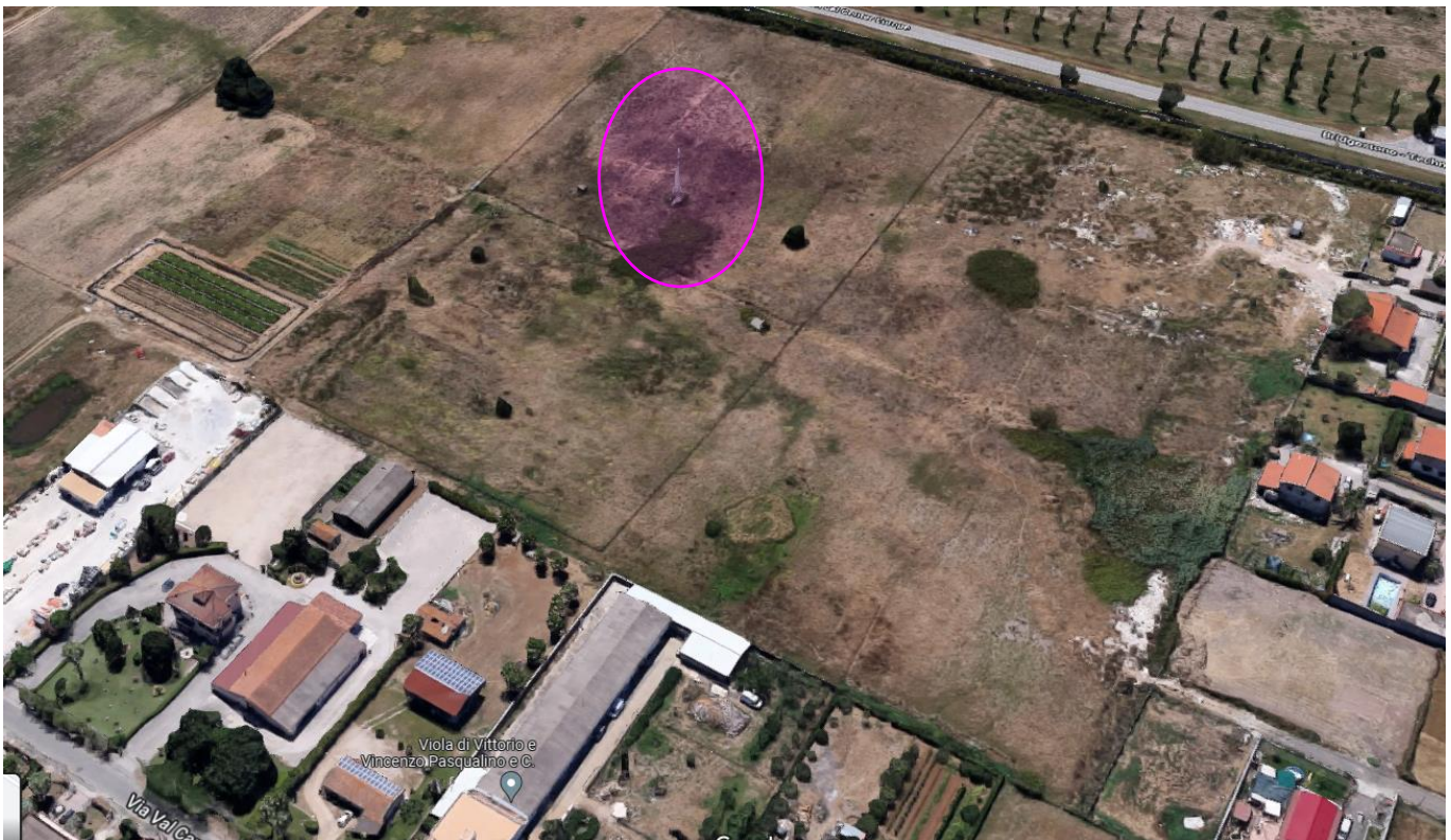
Figura 35 Traliccio da Rimuovere P26 – vista aerea
