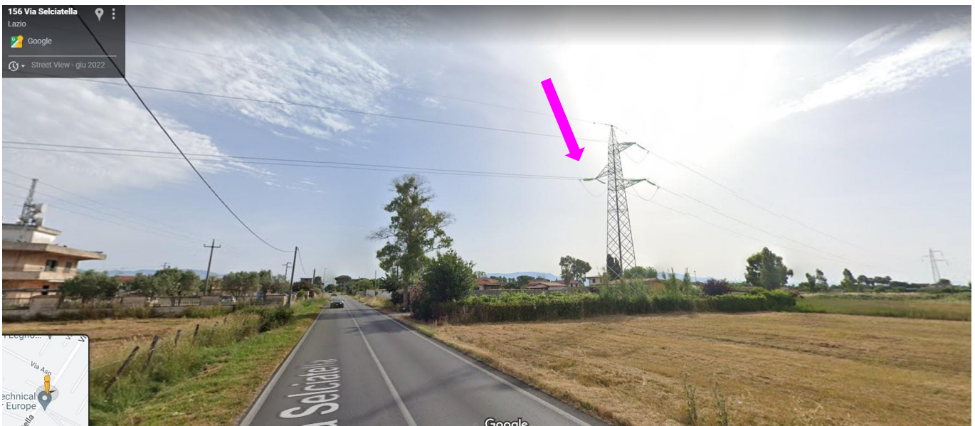
Figura 27 Traliccio da rimuovere P 23 vista da via Selciatella
