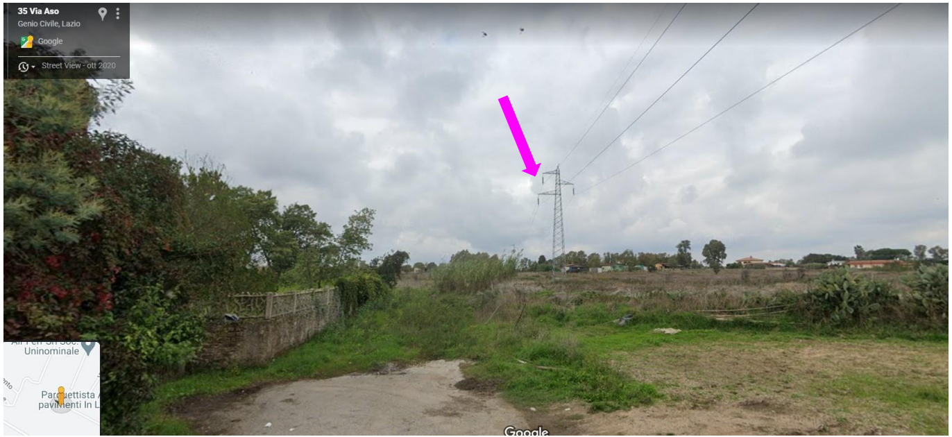
Figura 19 Traliccio da rimuovere P 21 vista da via Aso
