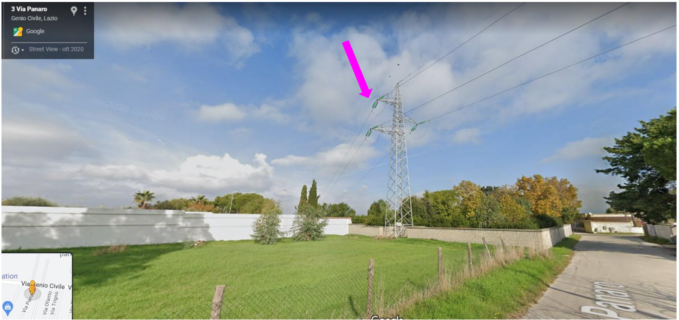
Figura 7 Traliccio da rimuovere P 17 vista da via Panaro
