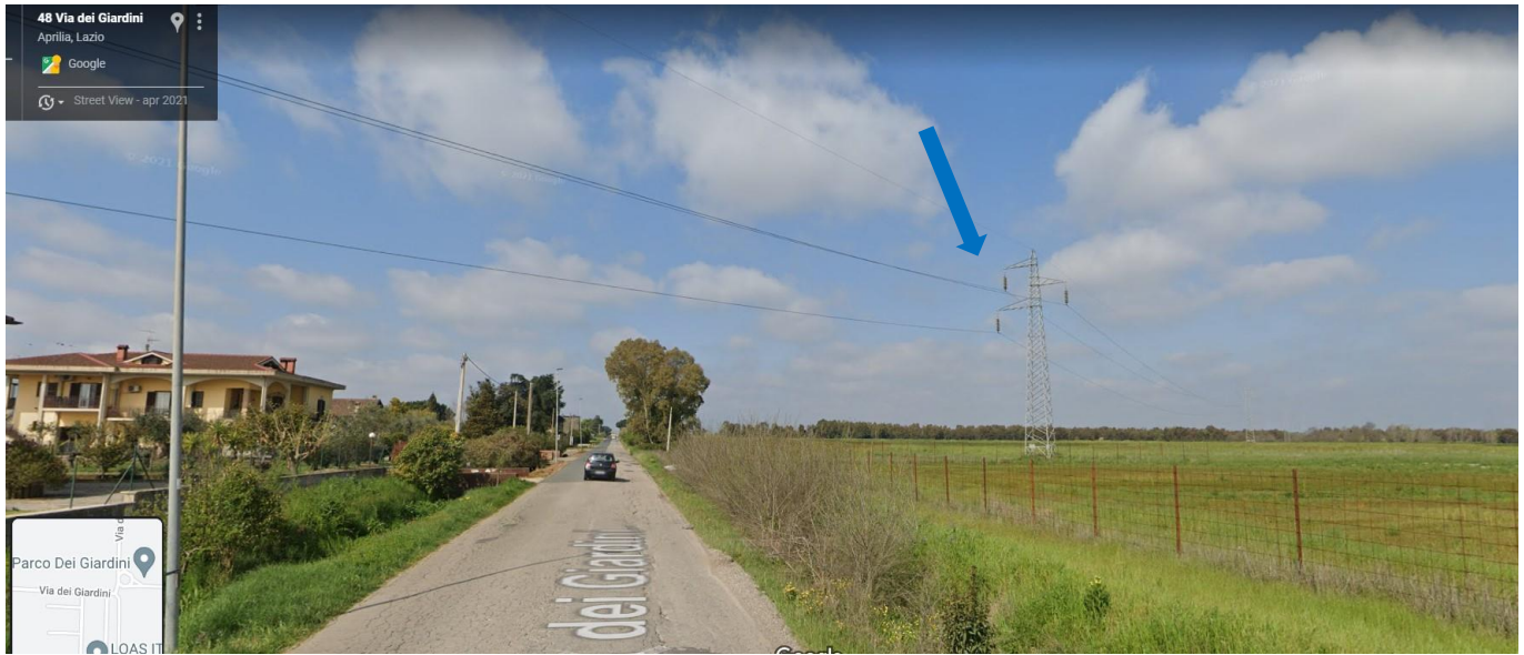
Figura 53 Sostegno P10 da sostituire - vista da via dei Giardini
