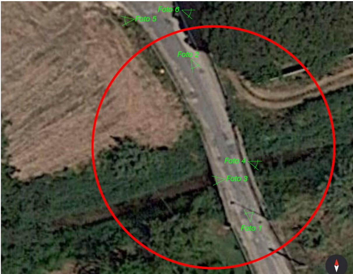
Figura 72 Rilievo fotografico attraversamento corso d'acqua naturale secondario " Fosso delle Cannucce"
