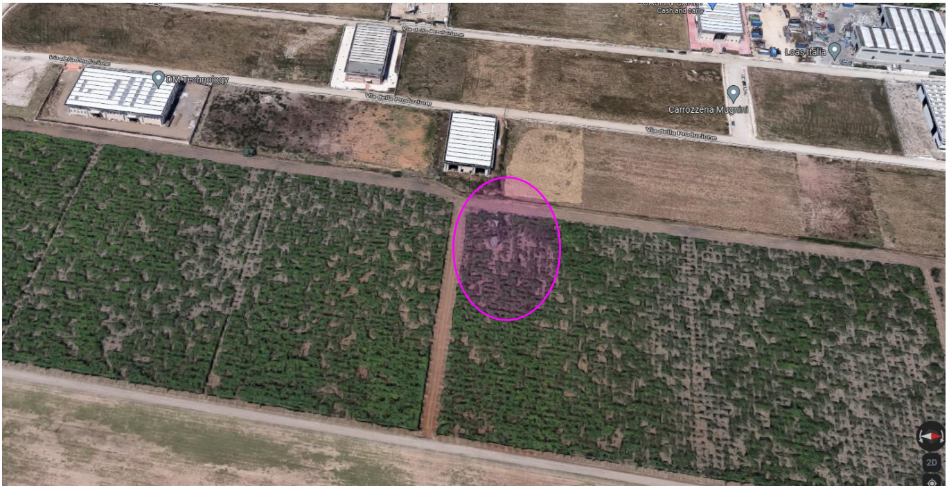
Figura 3 Traliccio P15 da rimuovere - vista Aerea
