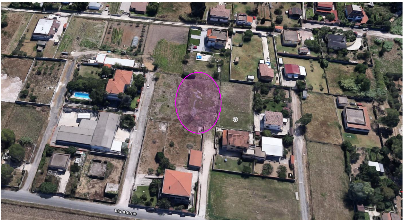
Figura 12 Traliccio da rimuove P 19 vista aerea
