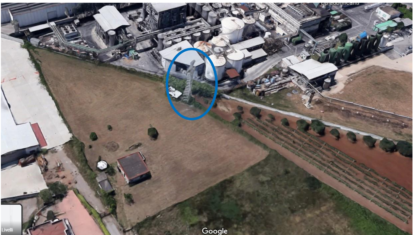
Figura 49 - Sostegno P3 da sostituire - Vista Aerea
