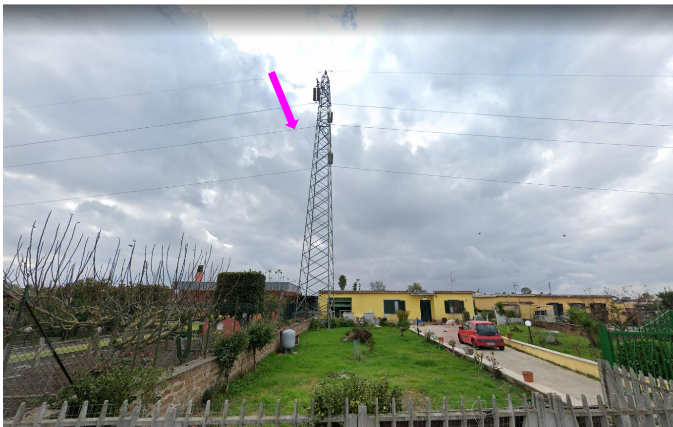
Figura 24 Traliccio da rimuovere P 22 vista da via Aso
