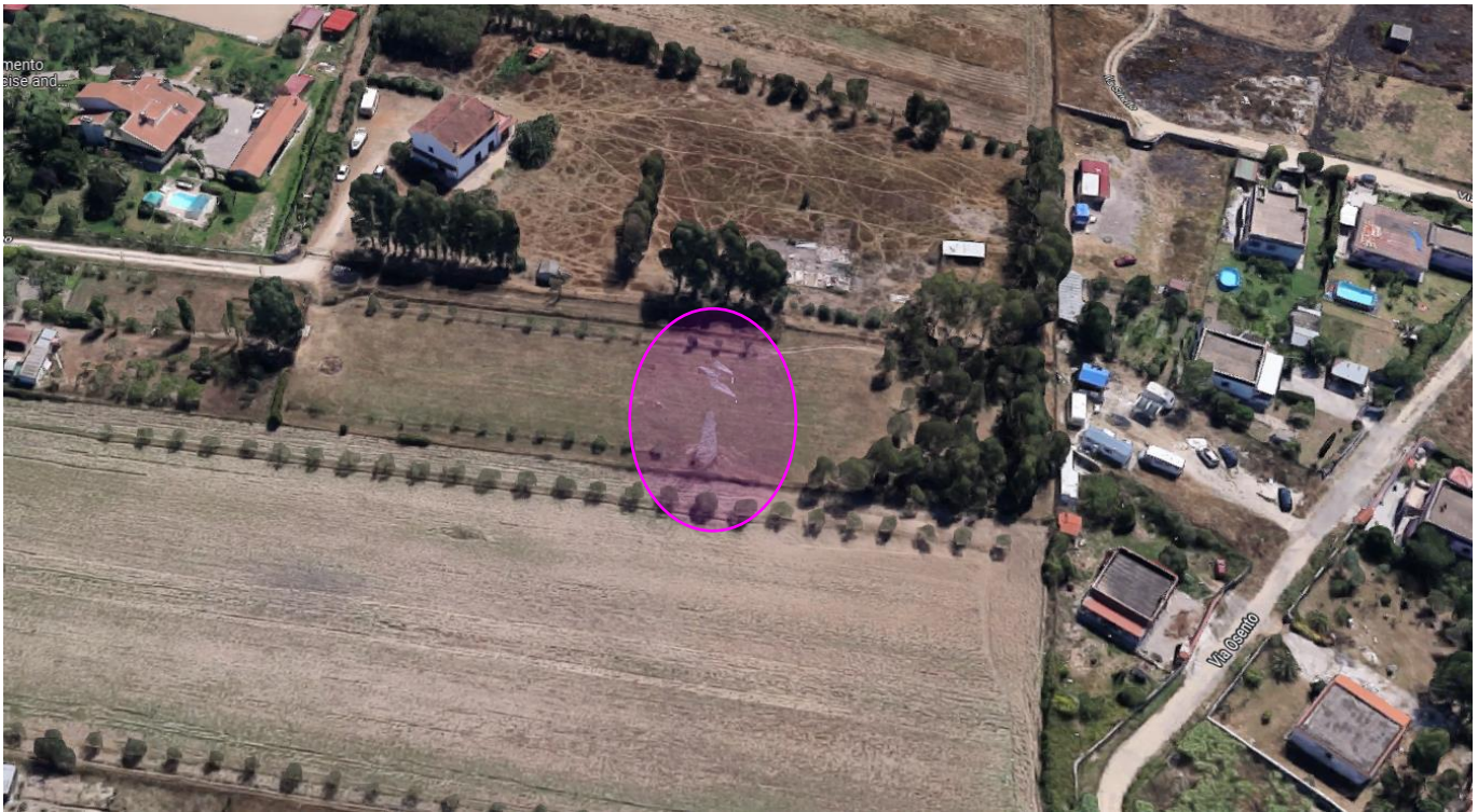
Figura 15 Traliccio da rimuovere P 20 vista aerea
