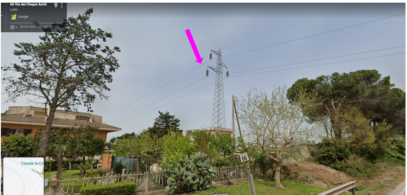
Figura 47 Traliccio da rimuovere P 30 vista da via Dei Cinque Archi
