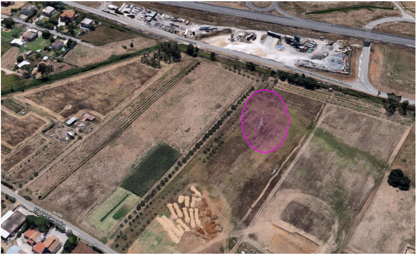
Figura 38 Traliccio da Rimuovere P27 – Vista aerea
