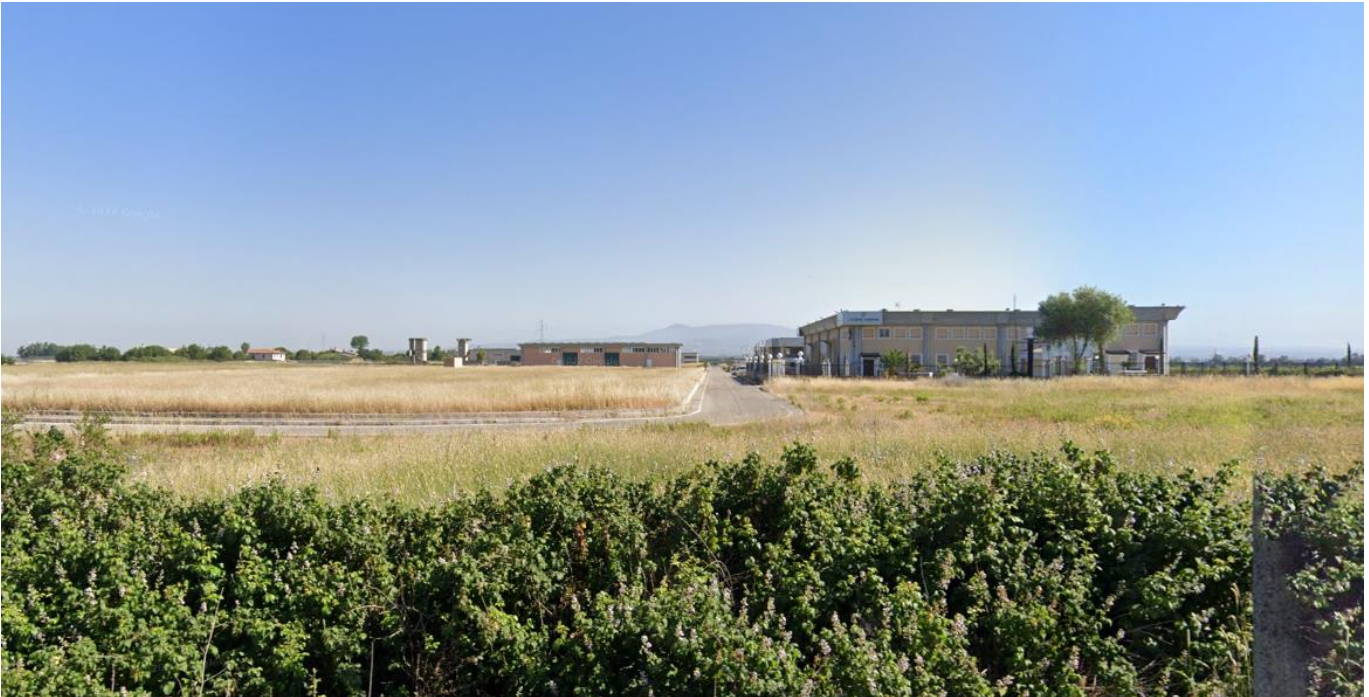
Figura 79 via dell'Artigianato vista da via Genio Civile
