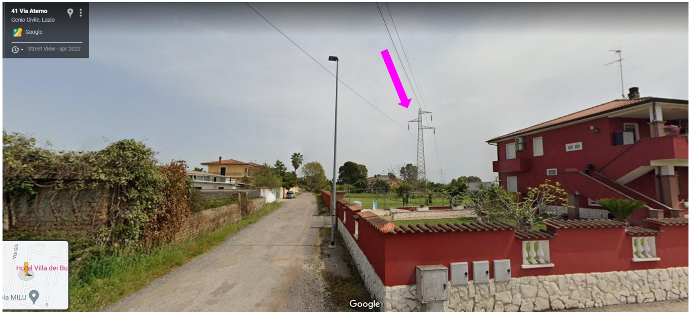
Figura 13 Traliccio da rimuovere P 19 vista da via Aterno
