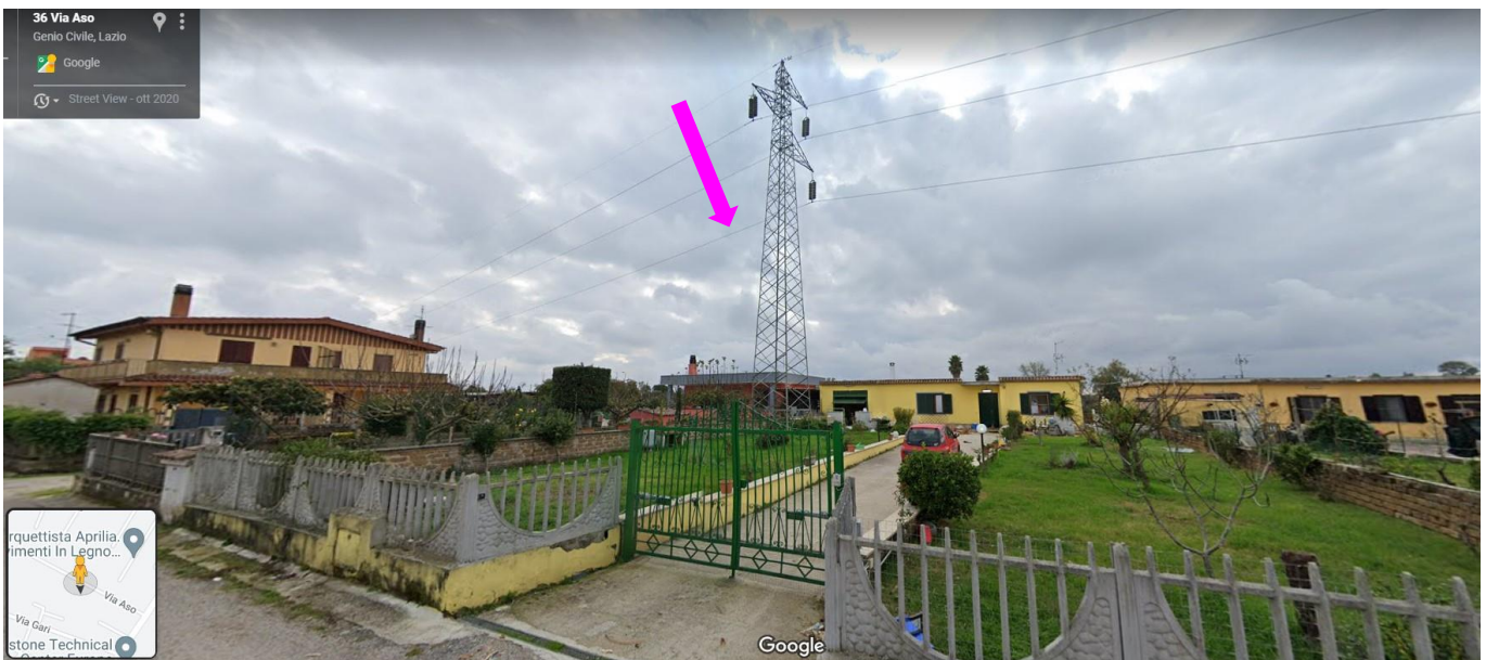
Figura 23 Traliccio da rimuovere P 22 vista da via Aso
