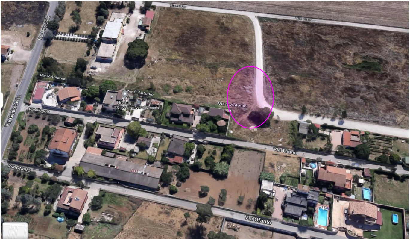
Figura 9 Traliccio da rimuovere P 18 vista aerea
