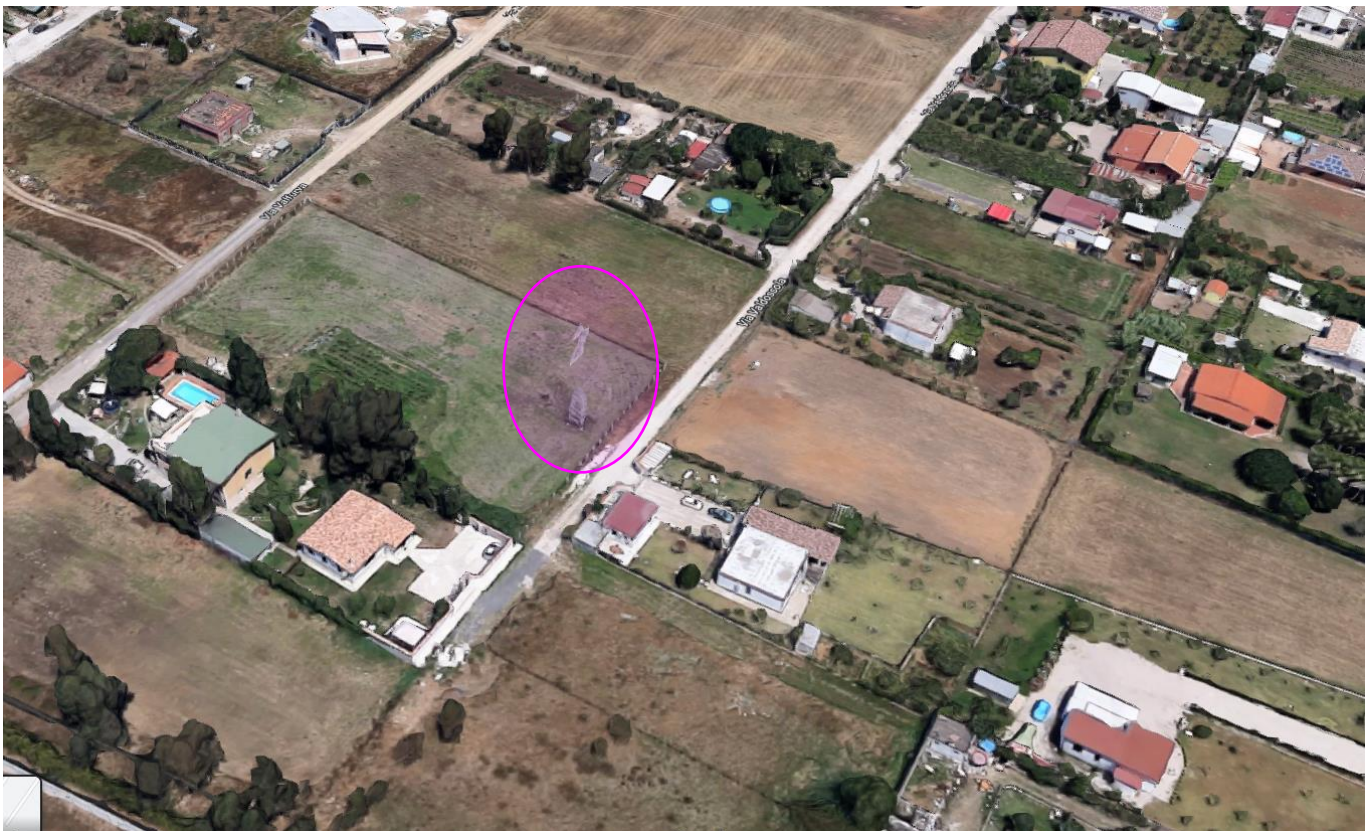
Figura 29 Traliccio da Rimuovere P24 – Vista aerea
