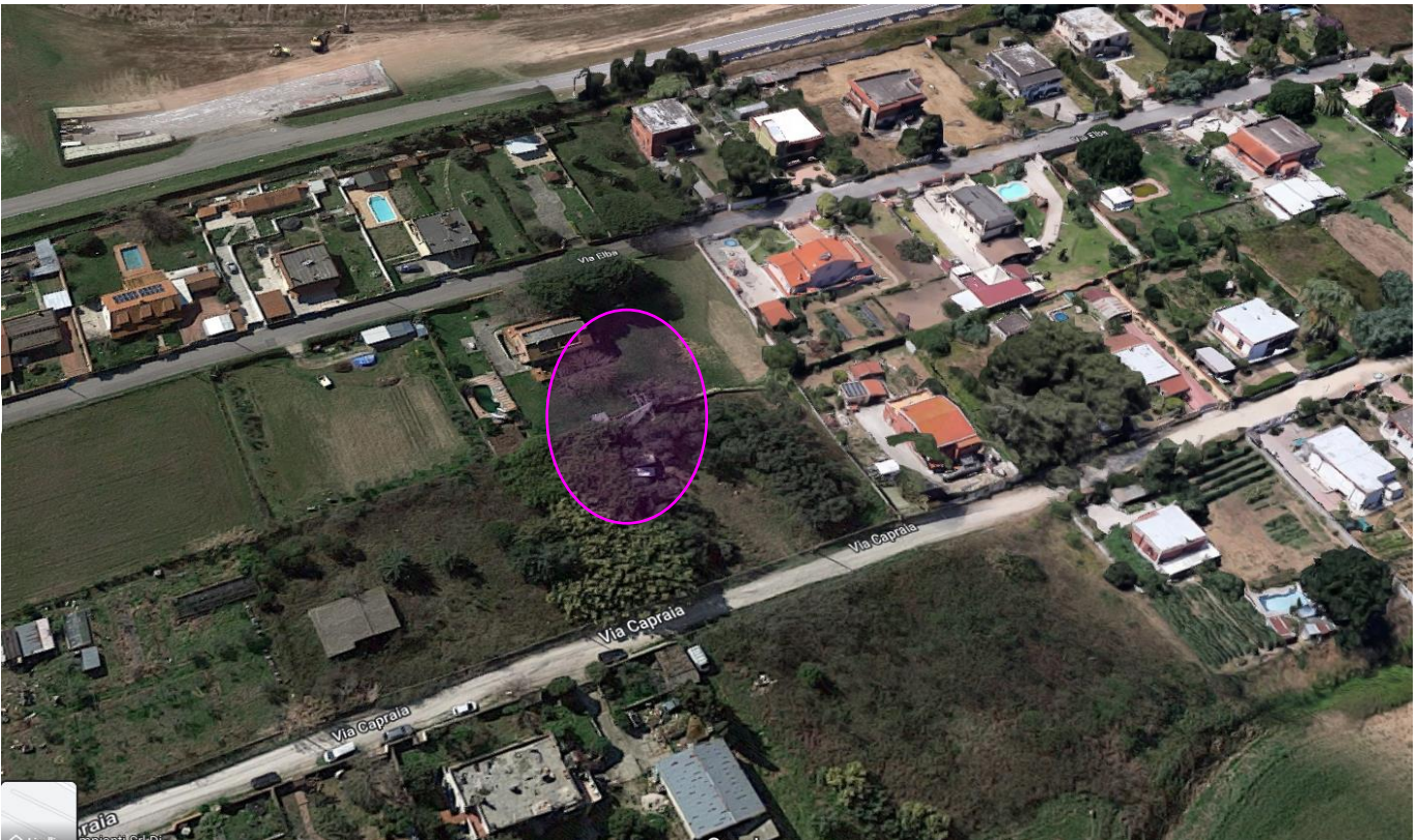
Figura 44 Traliccio da rimuovere P29 - Vista aerea
