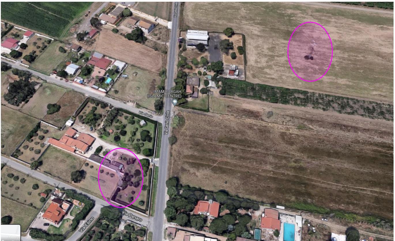
Figura 4 Tralicci P16 e P17 da rimuovere - vista Aerea
