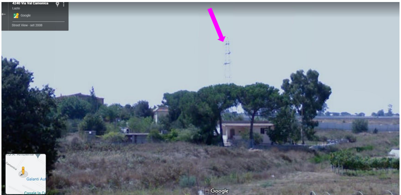
Figura 42 Traliccio da rimuovere P 28 vista da via Val Camonica
