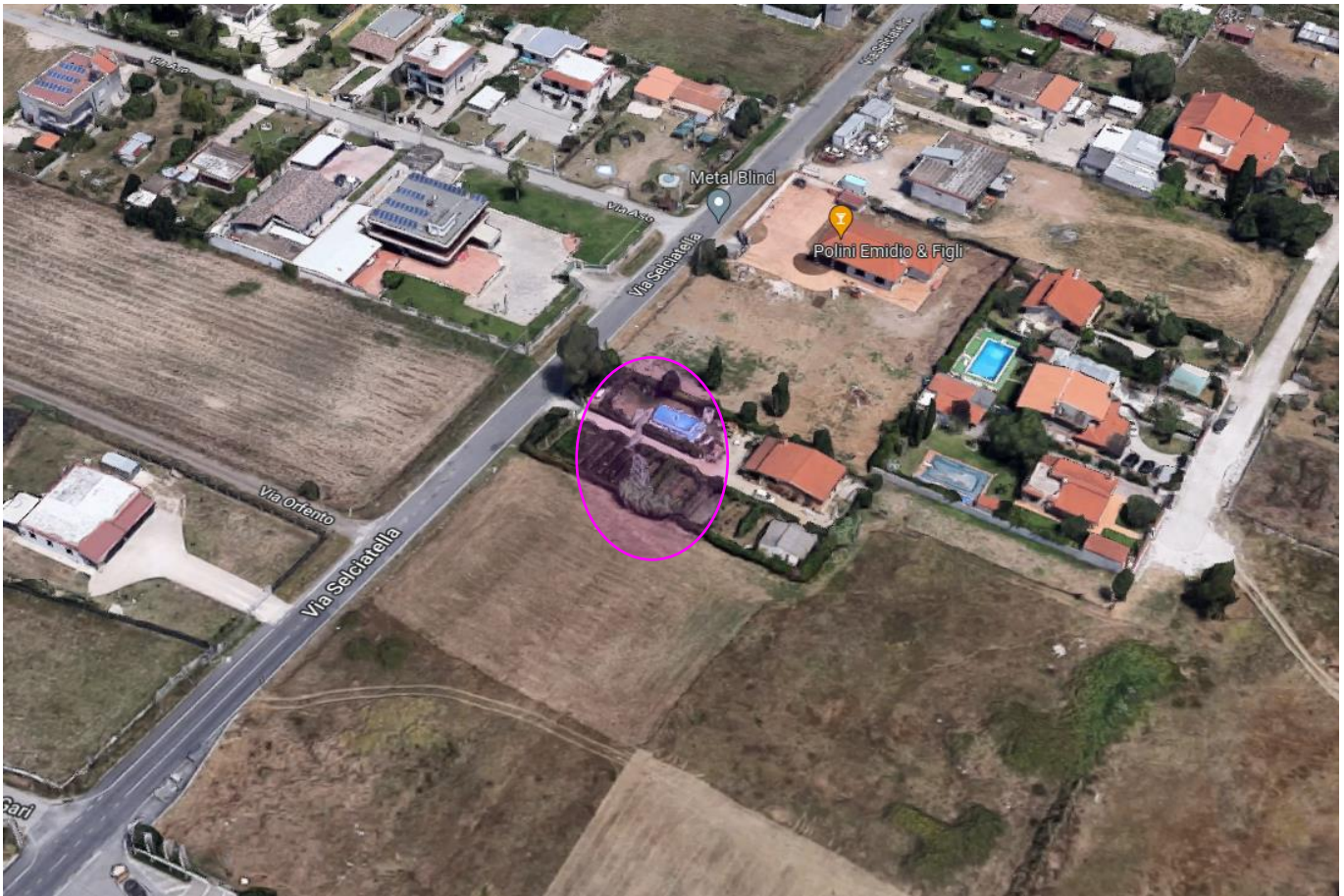
Figura 26 Traliccio da rimuovere P 23 vista aerea
