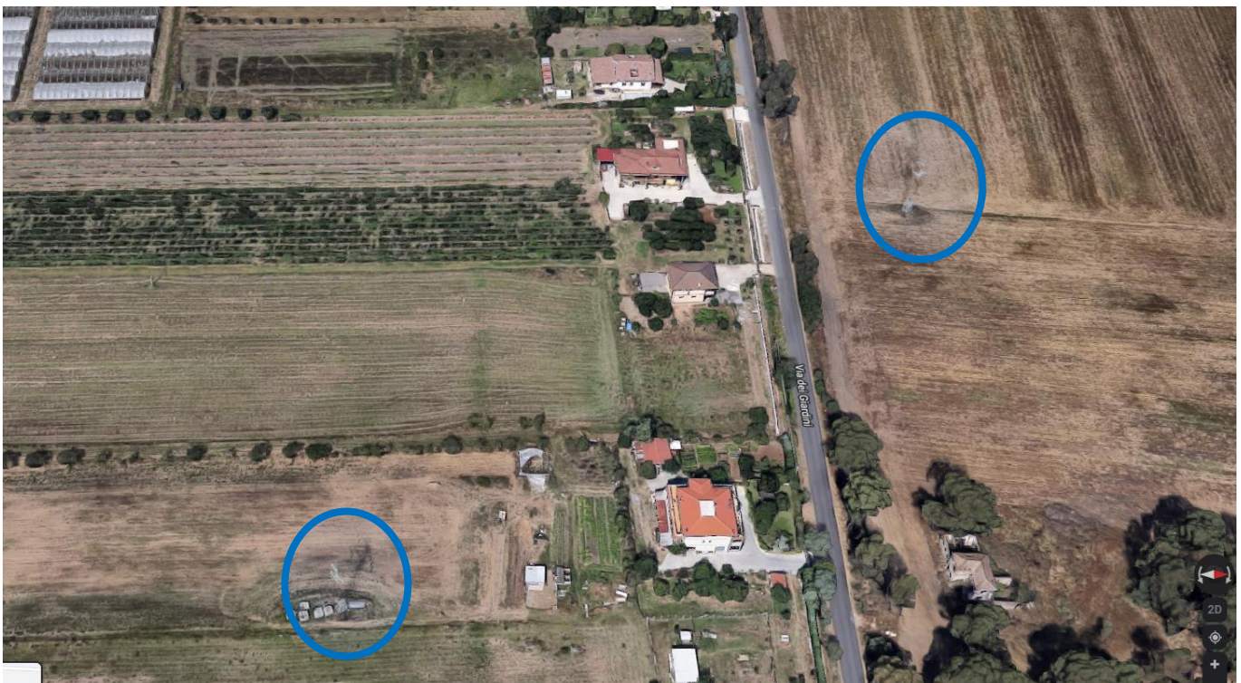
Figura 52- - Sostegni P10 e P11 – vista aerea
