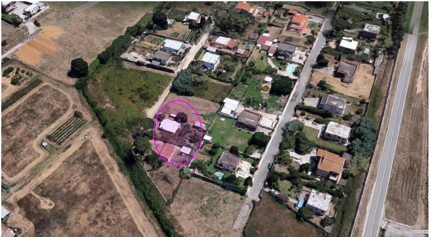
Figura 41 Traliccio da Rimuovere P28 – Vista aerea
