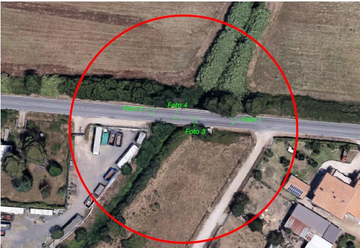
Figura 19. Rilievo fotografico attraversamento corso d'acqua naturale Rio Torto
