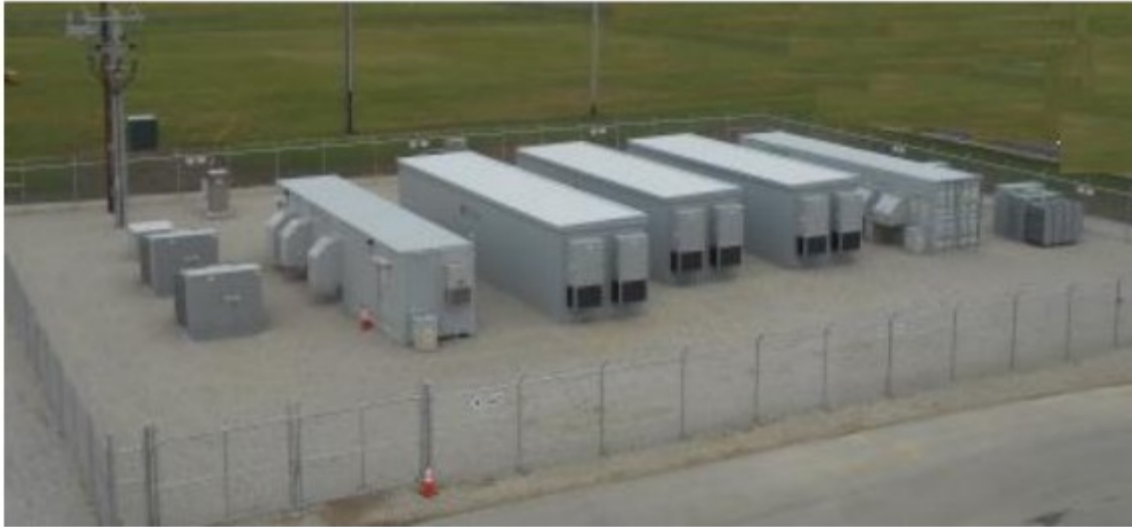
Figura 15: Sistema tipo area accumulo elettrochimico
