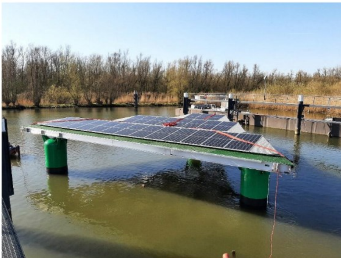
Figura 4: Esempio di piattaforma triangolare galleggiante per la produzione di energia fotovoltaica (fonte: https://solarduck.tech )
