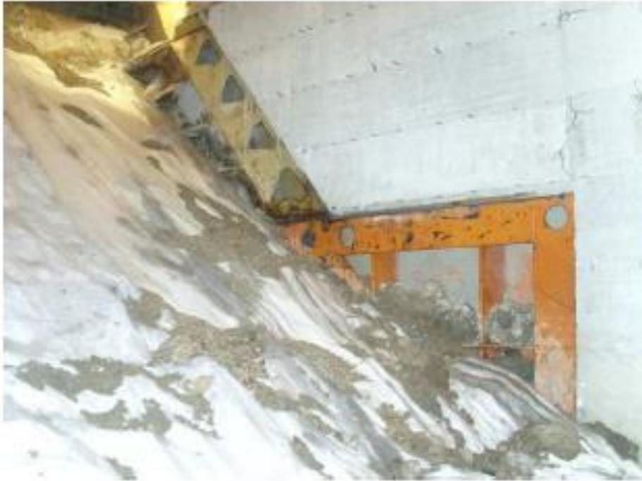
**Figura 11: Messa in sicurezza e protezione del fronte di scavo per una pausa lunga**
