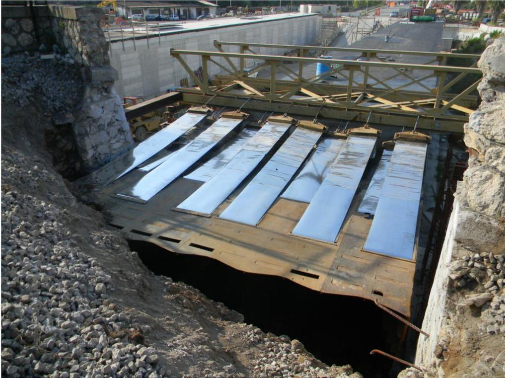
Figura 6: Svolgimento dei nastri di trascinamento a inizio infissione
