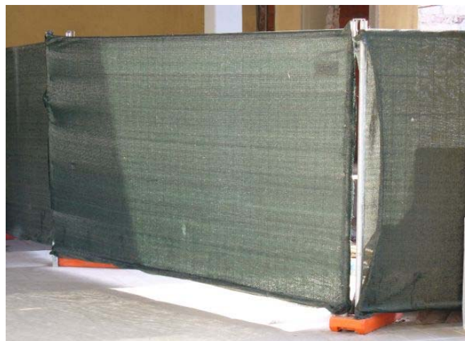
Figura 6: Telo antipolvere da cantiere
