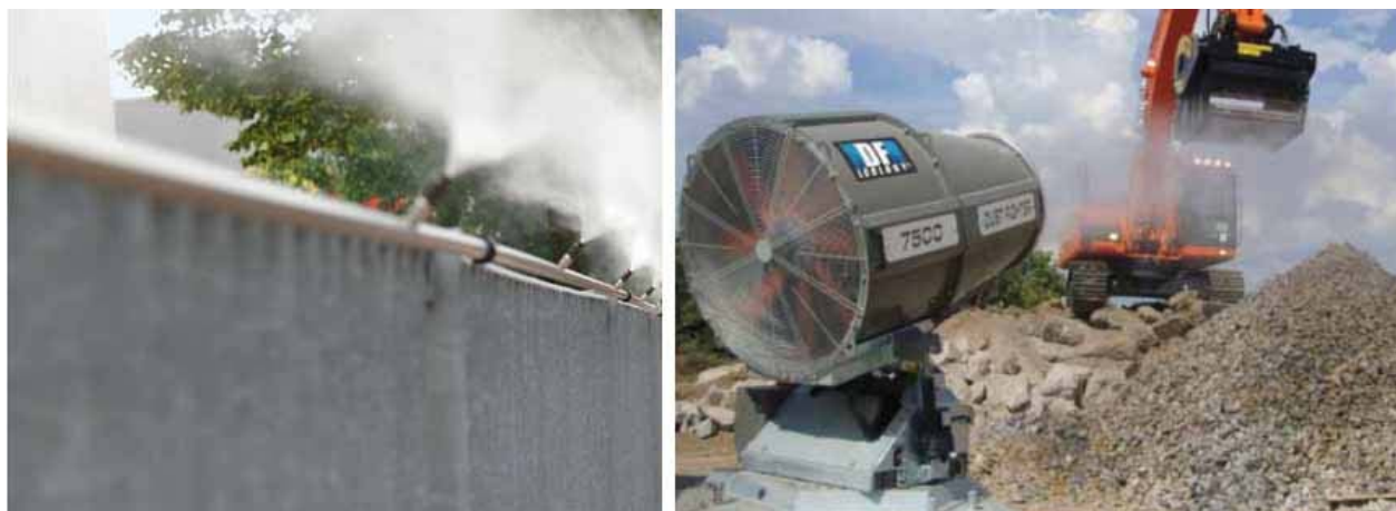
Figura 5: Sistemi di nebulizzazione per l'abbattimento delle polveri
