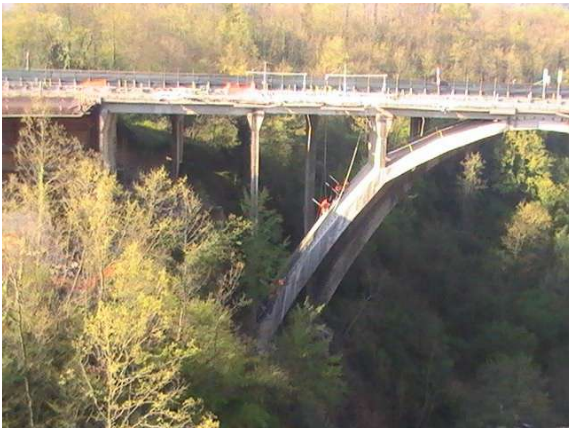
Foto 37. a. e “b”. Perforazione fori da mina sull'arco, con carotieri a diamante. Il personale accede all'arco con imbragatura, assicurato alla linea di vita. La perforazione delle camere di scoppio cilindriche consente l'inserimento delle cariche per l'asportazione del calcestruzzo su ampie fasce d'arco per l'innescò delle cerniere e la demolizione di segmenti di arco.
