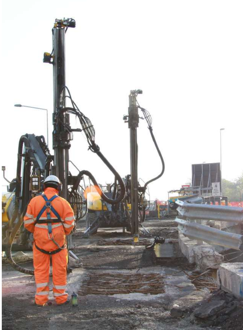
Foto 35.a. e "b". Perforazione fori da mina su arco e travi, con carri di perforazione idraulici radiocomandati.
