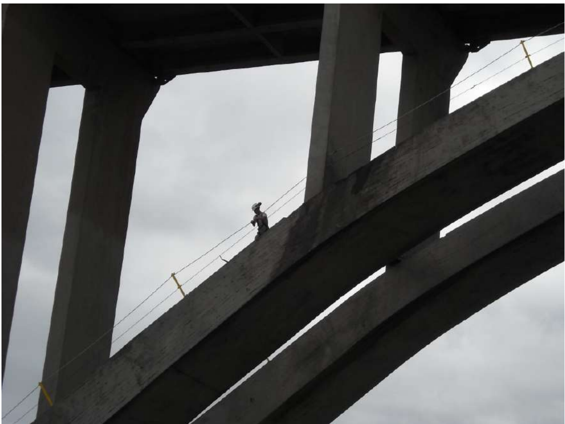
Foto 31. Linee di vita (es. sull'arco), anche con funzione di parapetto. Accesso sull'arco facilitato da scale realizzate con traversi di legno fissati a cavo d'acciaio (facilmente removibili prima dello sparo del ponte).
