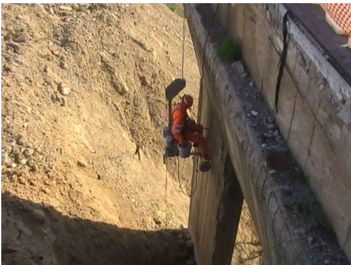
Foto 38. a. e “b”. Perforazione fori da mina sulle stilate, da navicella sospesa, vincolata ad una trave zavorrata posta sull'impalcato (foto “a”). Mediante questo sistema è possibile perforare le stilate a qualsiasi altezza, anche sull'arco, la dove l'utilizzo di piattaforme aeree non sarebbe possibile per la impassibilità di stazionamento sul sedime. La perforazione è effettuata con martelli elettrici a rotopercussione o pneumatici.
