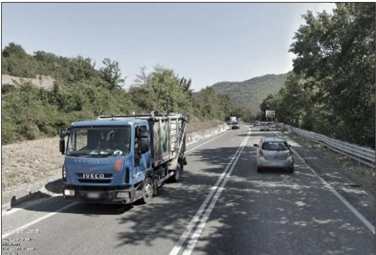
Figura 11: S.S. 4 Salaria esistente - tratti con divieto di sorpasso (streetview)
