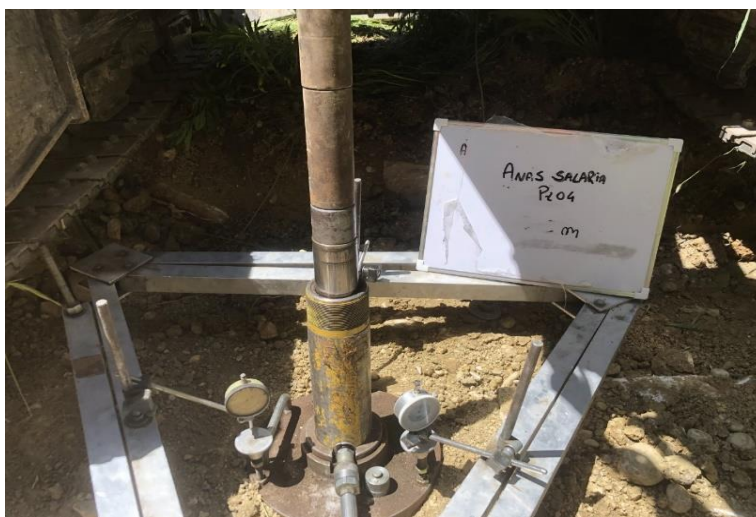
Prova di carico su piastra
