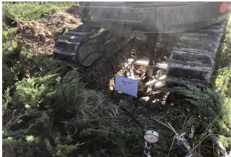
Prova di carico su piastra
