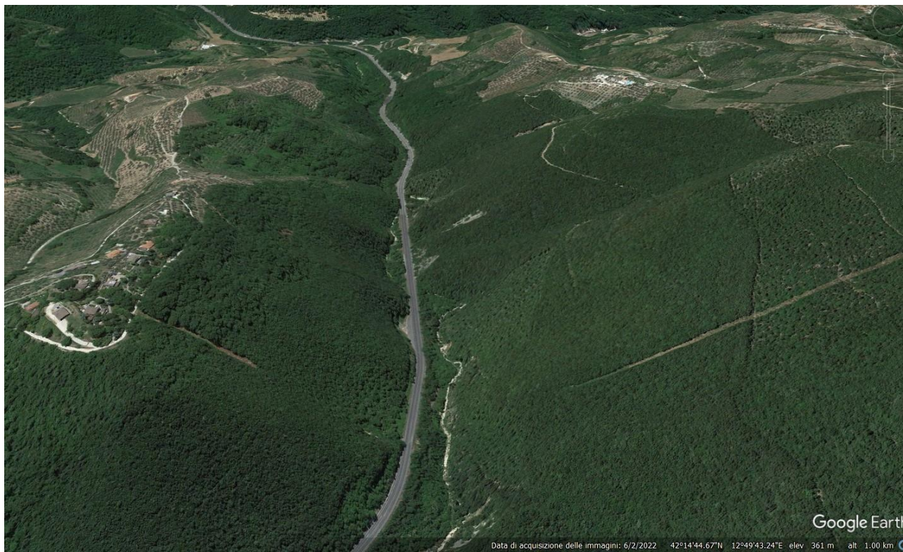
Figura 11 – Vista panoramica del tracciato da Nord
