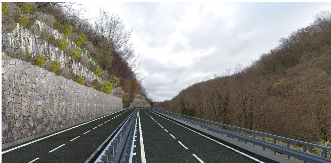
Figura 2 – Configurazione finale delle trincee (schema illustrativo)
