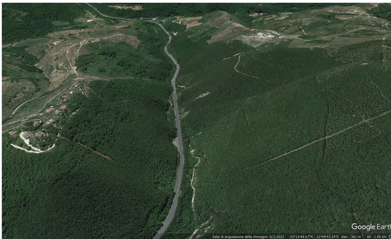
Fig. 4.2 – Vista panoramica del tracciato da Nord
