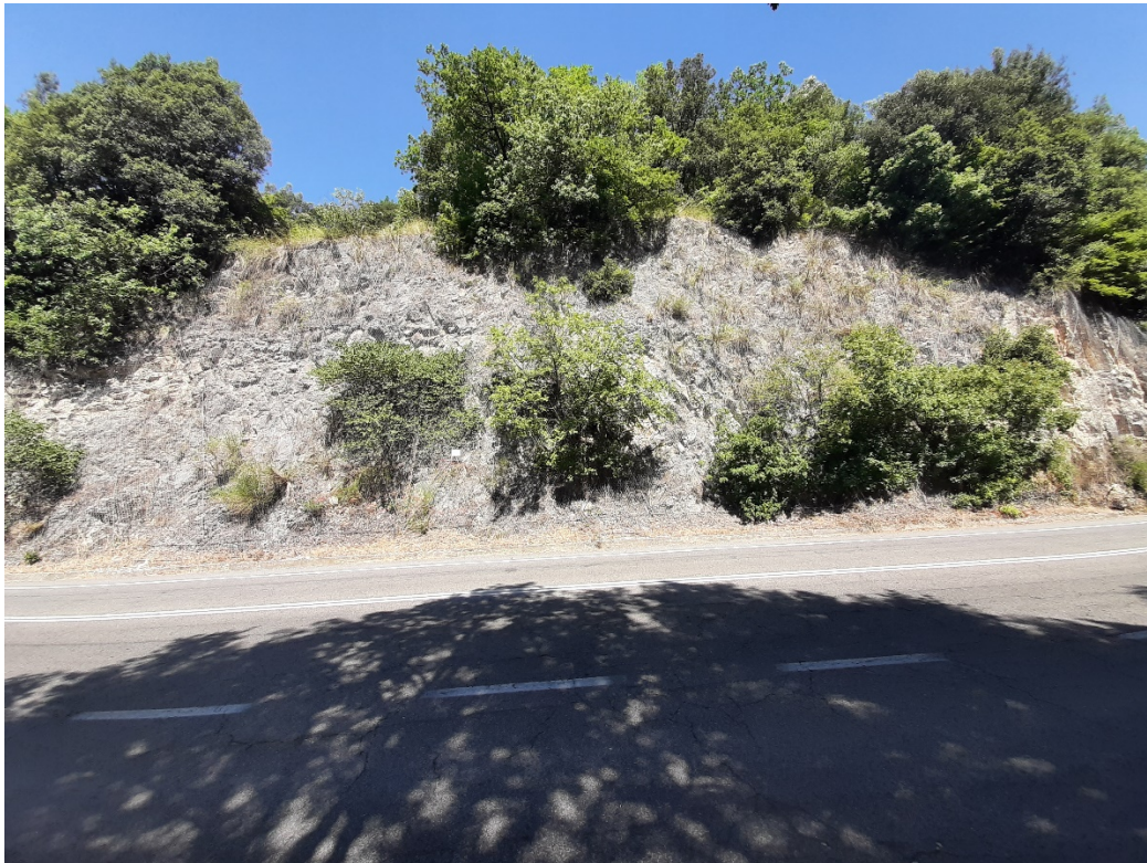
Fig. 3.2.2 – Affioramento dei calcari marnosi della Scaglia rossa (Km 0+540 – Sez. 28)
