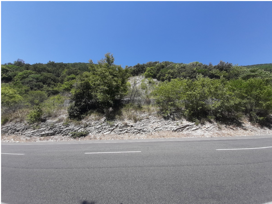
Fig. 3.2.4 – Affioramento dei calcari marnosi della Scaglia rossa (Km 1+660 – Sez. 84)
