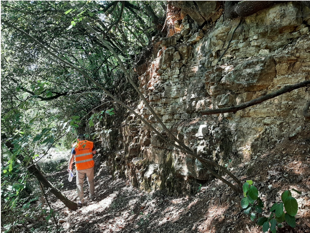
Fig. 3.2.3 – Affioramento dei calcari marnosi della Scaglia rossa (Km 0+580 – Sez. 30)
