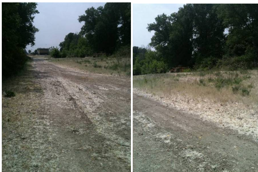
La pista di accesso al settore orientale
