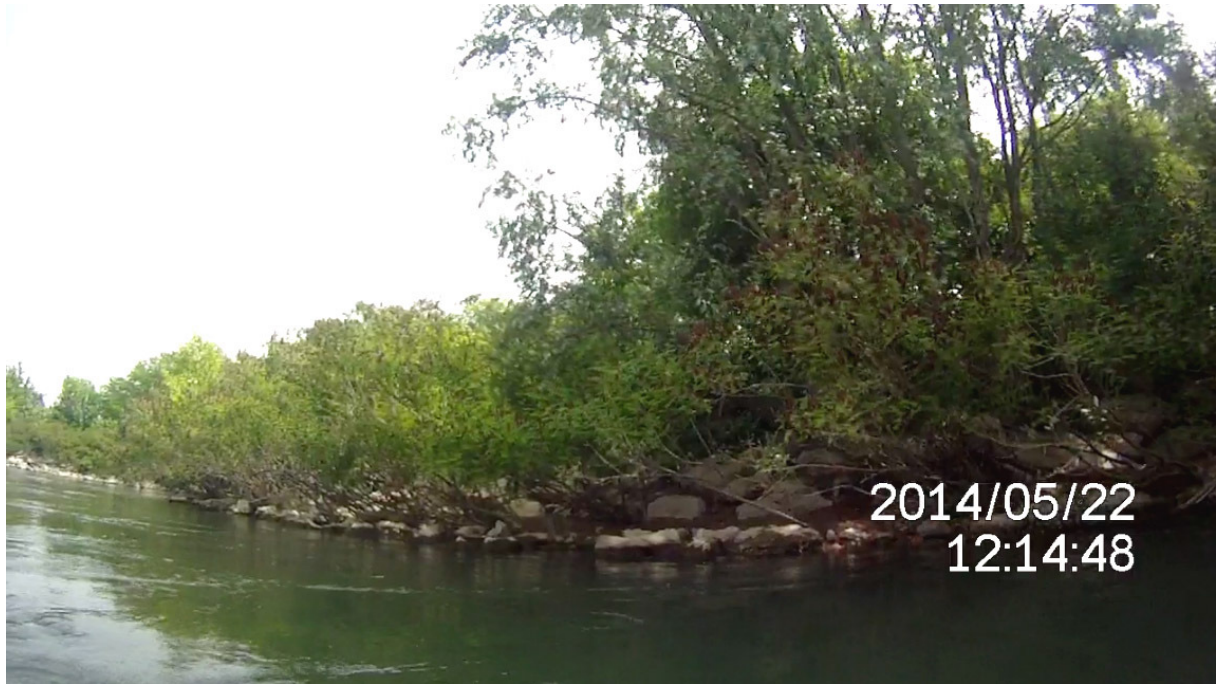
Massi ciclopici lungo la sponda del settore C, visti dal fiume
