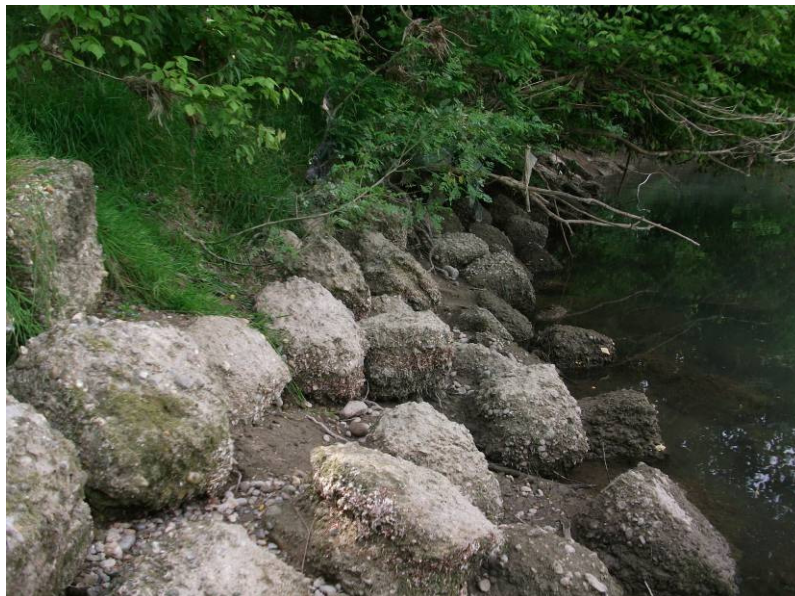
Massi lungo la sponda del settore B
