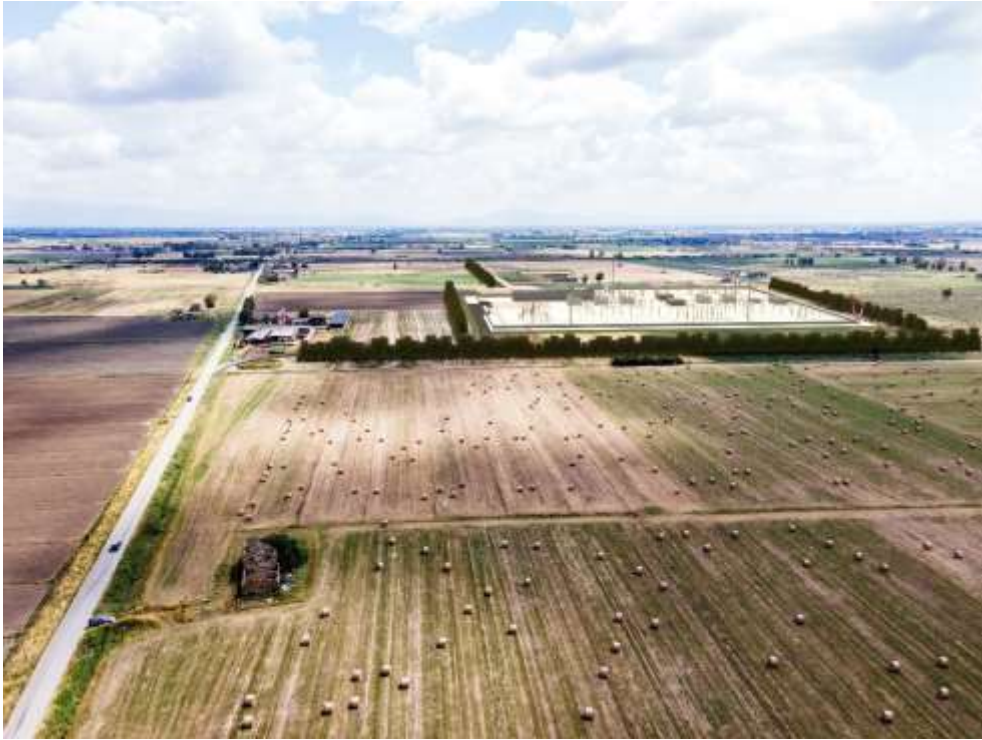
Figura 187: Fotoinserimento 4_vista con drone della SE e della Stazione di Utenza
