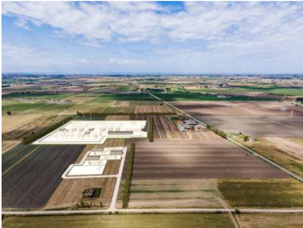
Figura 189: Fotoinserimento 5_vista con drone della stazione di utenza e della SE di RTN
