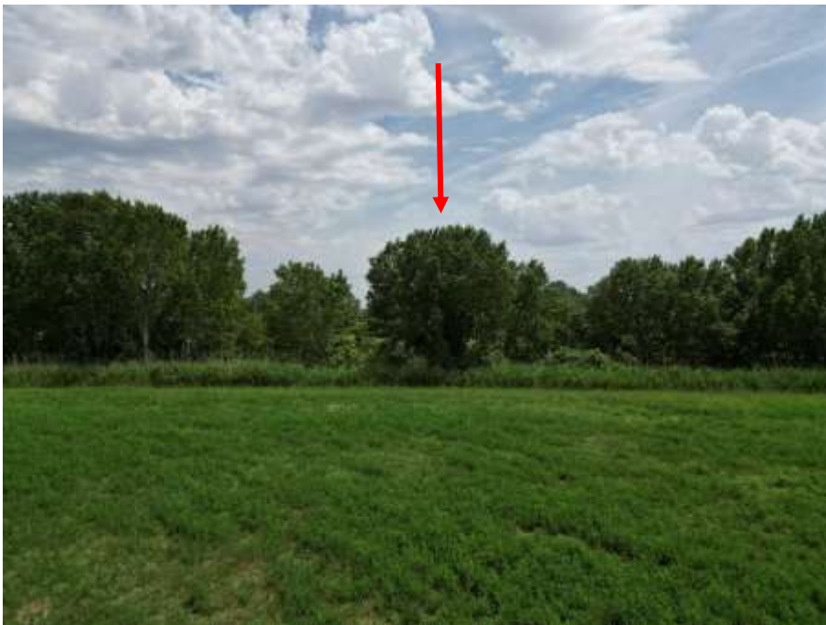
Figura 141: Foto 3_Vista dal Volturno della Stazione Elettrica
