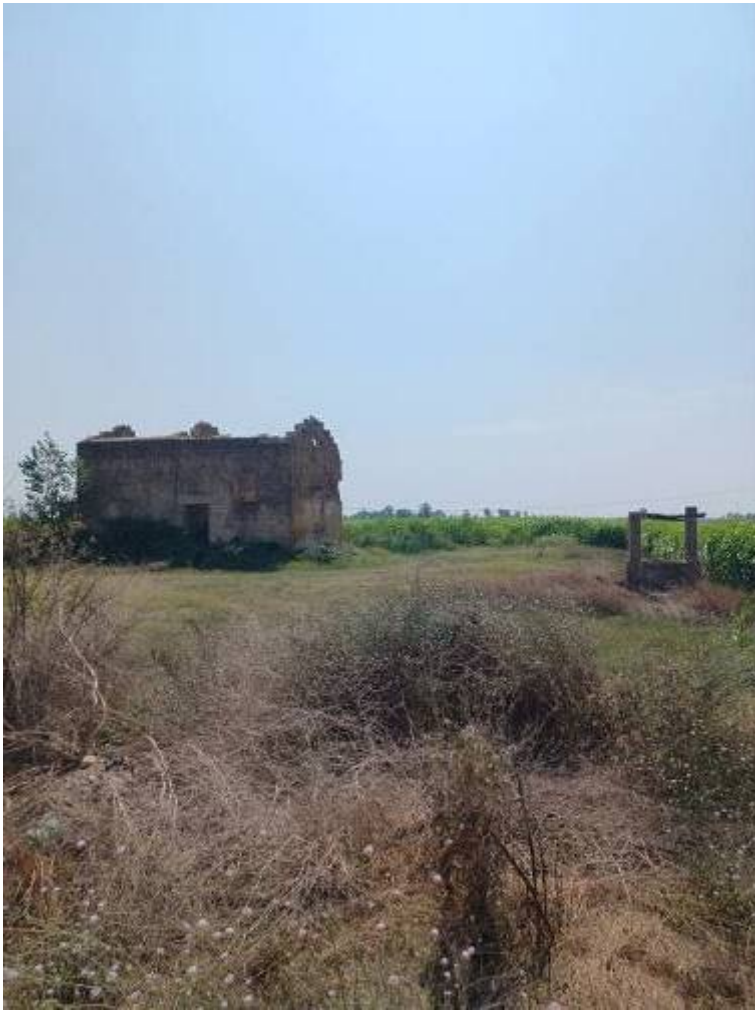
11 - VISTA DELL'AREA D'INTERVENTO CON IN PRIMO PIANO IL FABBRICATO ABBANDONATO E IL POZZO DALLA STRADA PODERALE "2".
