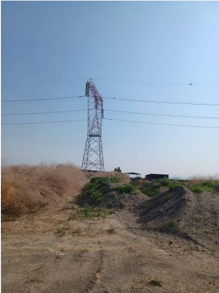
7 - VISTA DEL TRALICCIO “P77” DALLA STRADA PODERALE “1” IN DIREZIONE NORD-EST.
