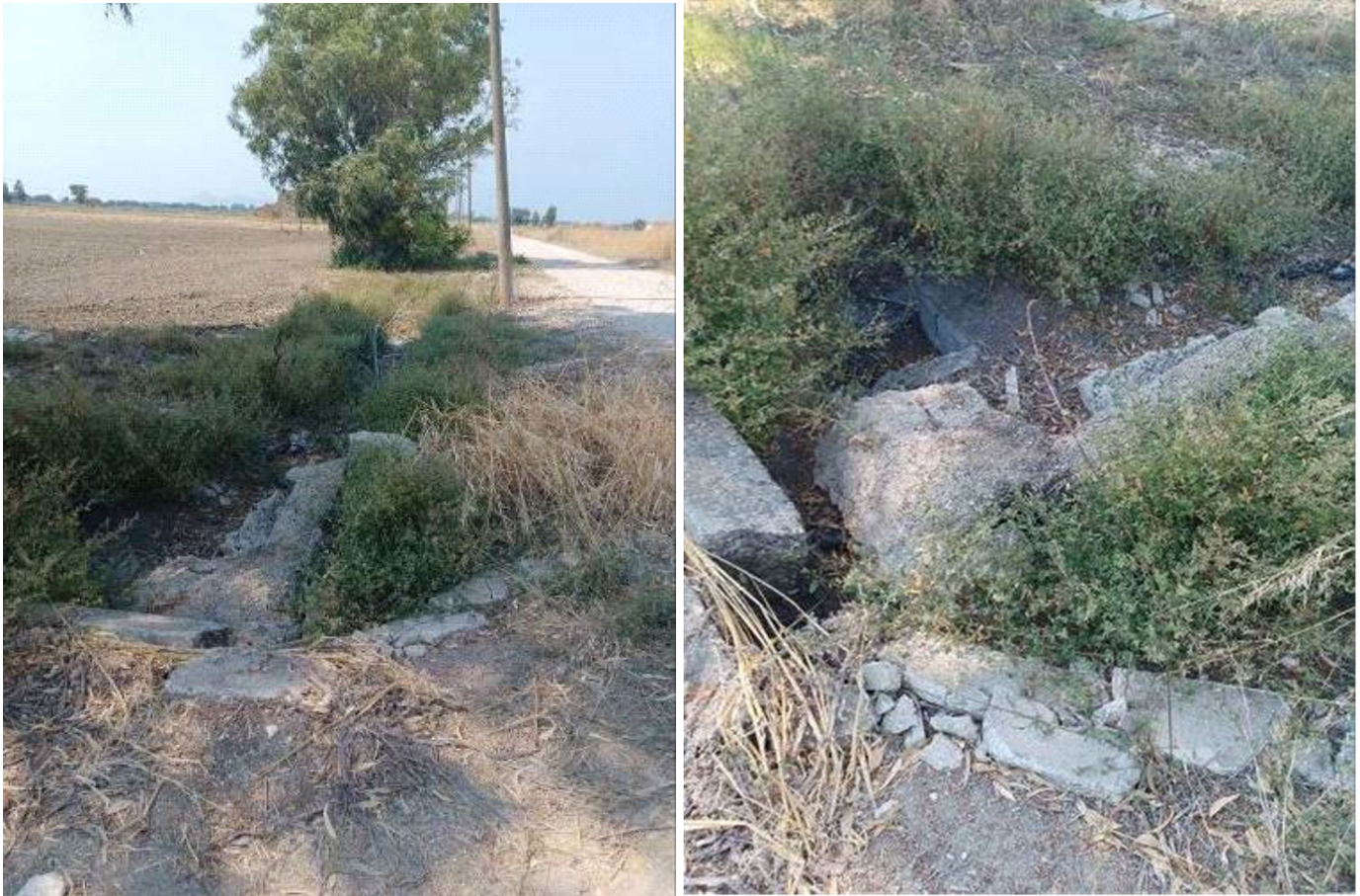
19/20 - VISTA DEL CANALE “B” DALLA STRADA PODERALE “2” VERSO VIA A. DIAZ.
