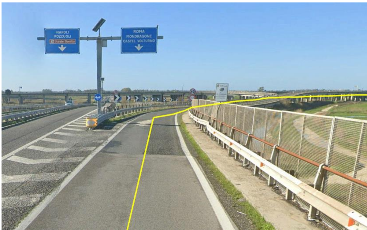
Figura 6: PUNTO3- Svincolo di uscita per ingresso sulla SS7qtr direzione Castelvolturno
