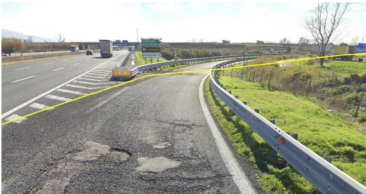
Figura 3: PUNTO 1 - Ingresso svincolo sulla SS7bis "Pomigliano-Villa Literno"
