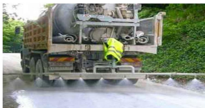
Bagnatura periodica delle superfici di cantiere
