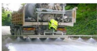
Bagnatura periodica delle superfici di cantiere
