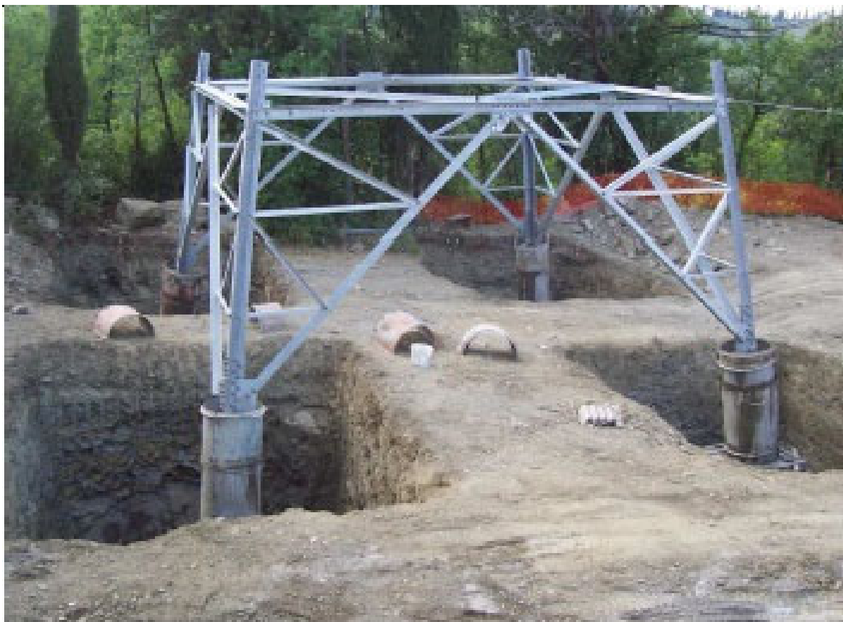
Figura 2-12: Realizzazione di fondazioni superficiali tipo CR per un sostegno a traliccio. Nell'immagine si possono osservare le quattro buche, la base del sostegno collegata alla fondazione tramite i "monconi" ed i casseri utilizzati per quattro "colonnini"
