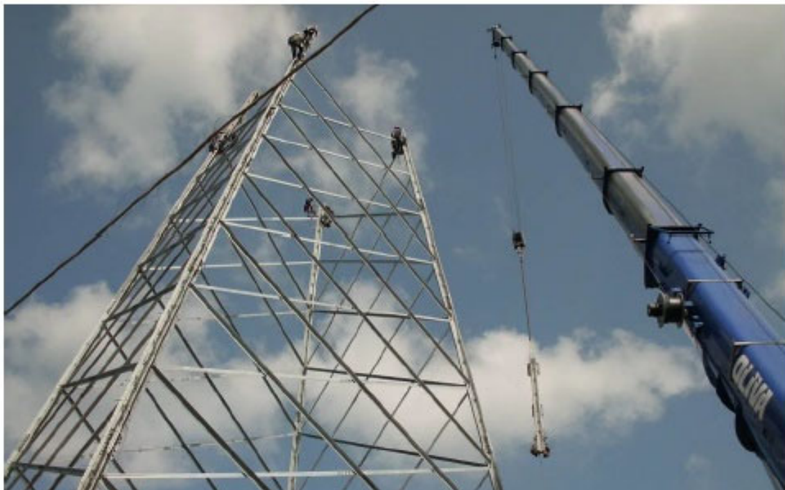
Figura 2-15: Fasi di montaggio sostegno a traliccio
