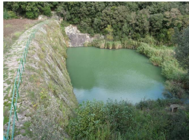
Figura 7: Diga di Vulci: Vista a valle
