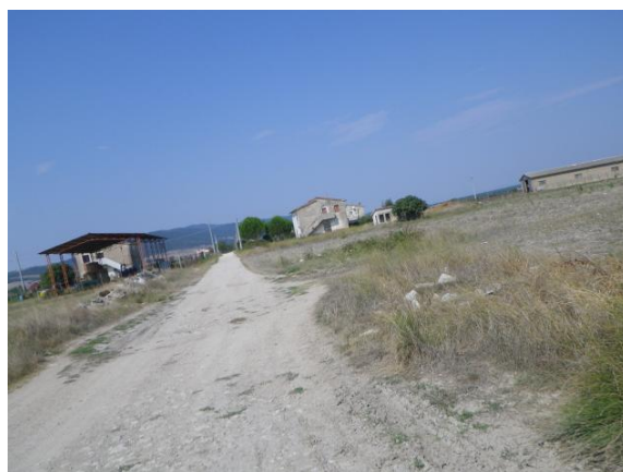
Foto F19 - Vista del percorso iniziale di accesso al bacino
