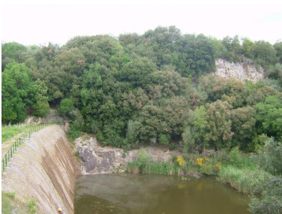
Foto F02 - Vista della diga e degli affioramenti litoidi in spalla sinistra
