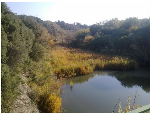
Foto F12 - Vista dell'area a valle diga (attuale)
