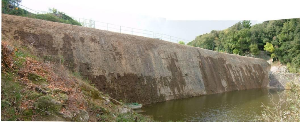
Foto F01 - Vista del paramento di valle della Diga di Vulci (Foto 2007)
