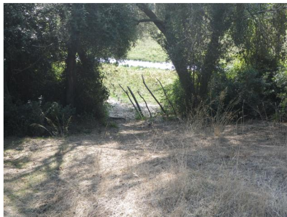
Foto F15 – Vista del passo di accesso a monte ed in sx idraulica del bacino creato dalla diga di Vulci
