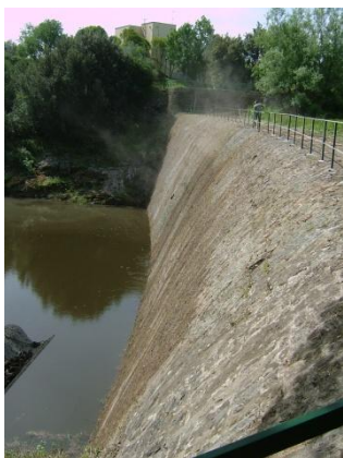
Foto F04 - Vista della diga e della spalla destra
