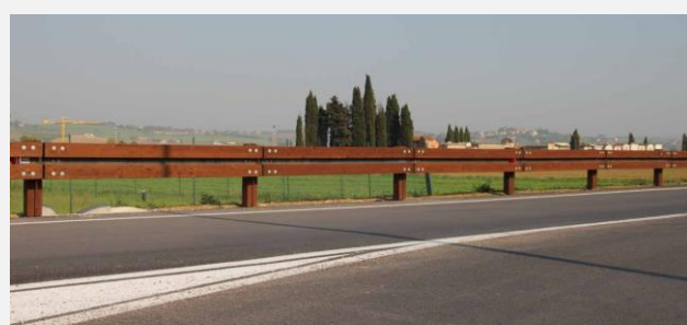
Sopra, Barriera in legno lamellare e acciaio corten in classe di contenimento H2 del tipo "bordo rilevato"
