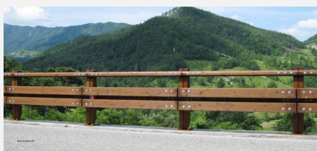
Sopra, Barriera in legno lamellare e acciaio corten in classe di contenimento H2 del tipo "bordo ponte"
