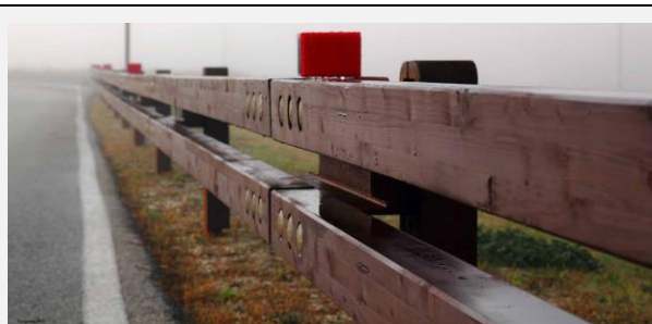
Sopra, Barriera in legno lamellare e acciaio corten in classe di contenimento H2 del tipo "bordo ponte"
