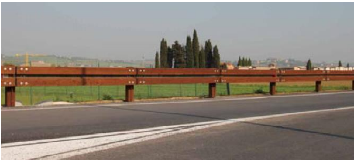
Figura 6.7 – Barriera in legno lamellare e acciaio corten
