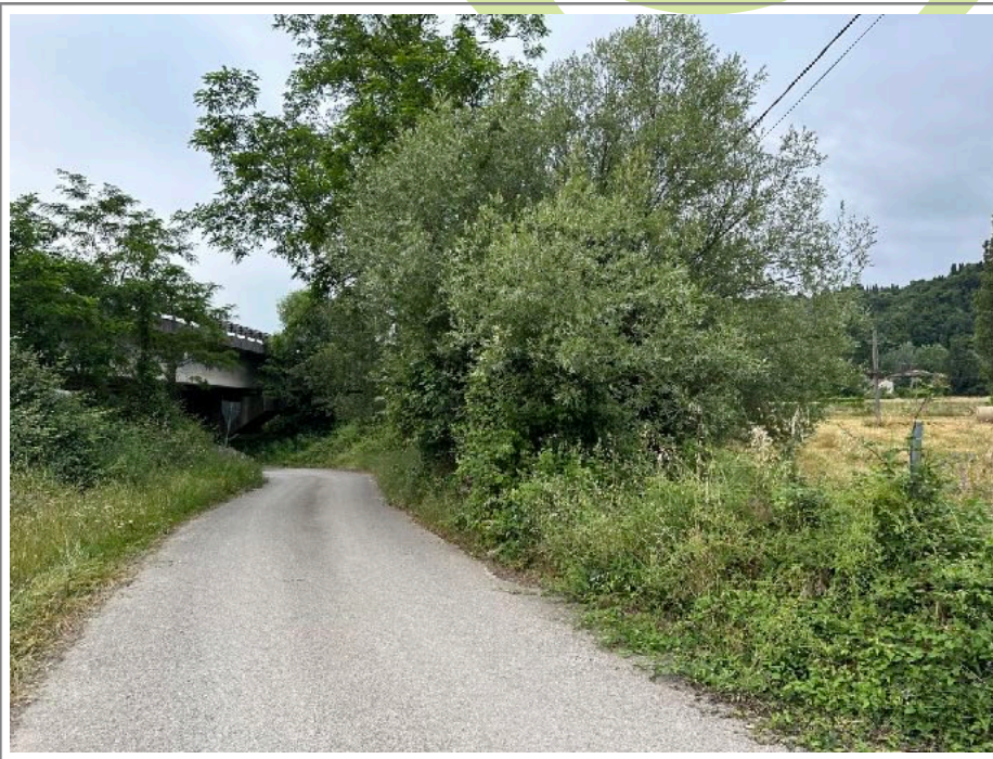
Foto 6. Vista viabilità minore lato nord ovest area di studio verso sottopasso SS 65.
