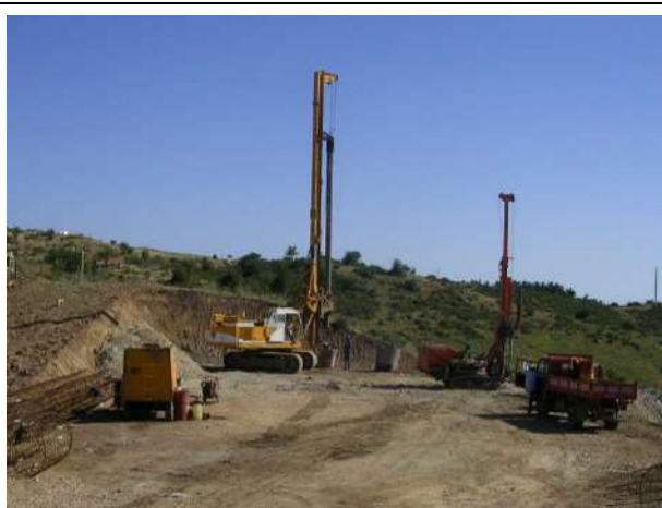
Realizzazione pali trivellati
