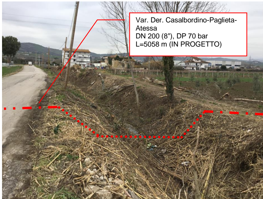
Foto n.13 – Var. Der. Casalbordino-Paglieta-Atessa DN 200 (8"), DP 70 bar (in progetto) con attraversamento fosso
