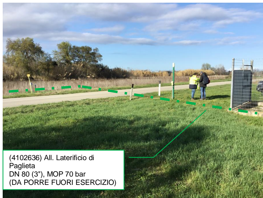
Foto n.2 – Vista con metanodotto da porre fuori esercizio
