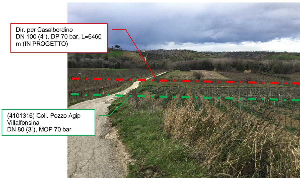
Foto n.6 – Panoramica metanodotti in progetto e metanodotto da porre fuori esercizio
