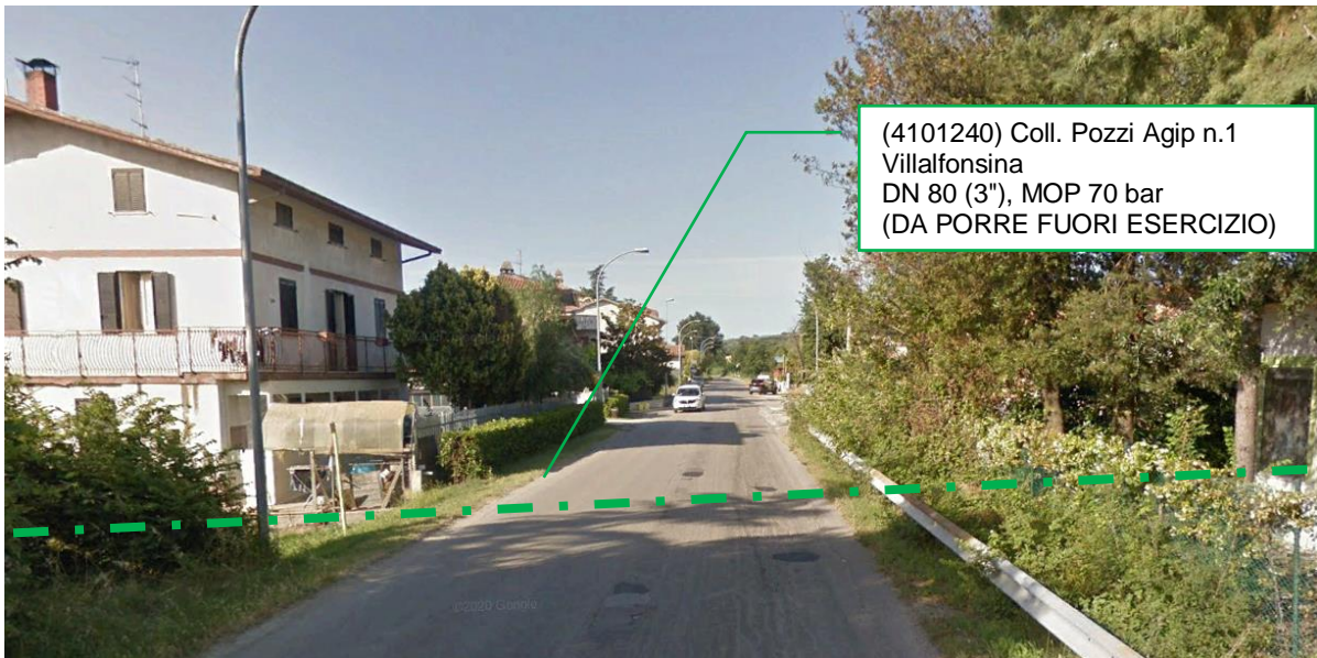
Foto n.1 – Vista metanodotto da porre fuori esercizio su attraversamento stradale
