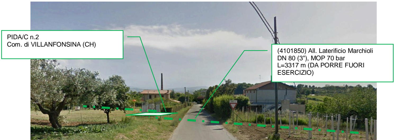
Foto n.8 – Panoramica metanodotto e impianto PIDA/C n.2 da porre fuori esercizio
