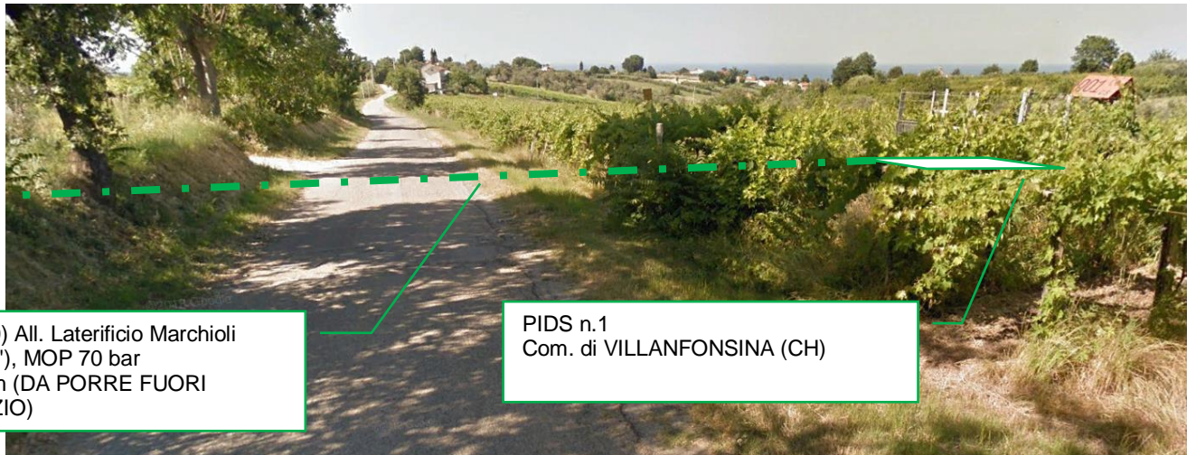
Foto n.7 – Panoramica metanodotto e impianto PIDS n. 1 da porre fuori esercizio
