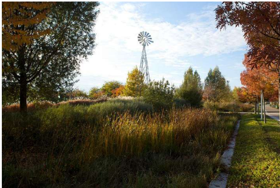
Figura 22: Vegetazione bassa in corrispondenza dei tralicci
