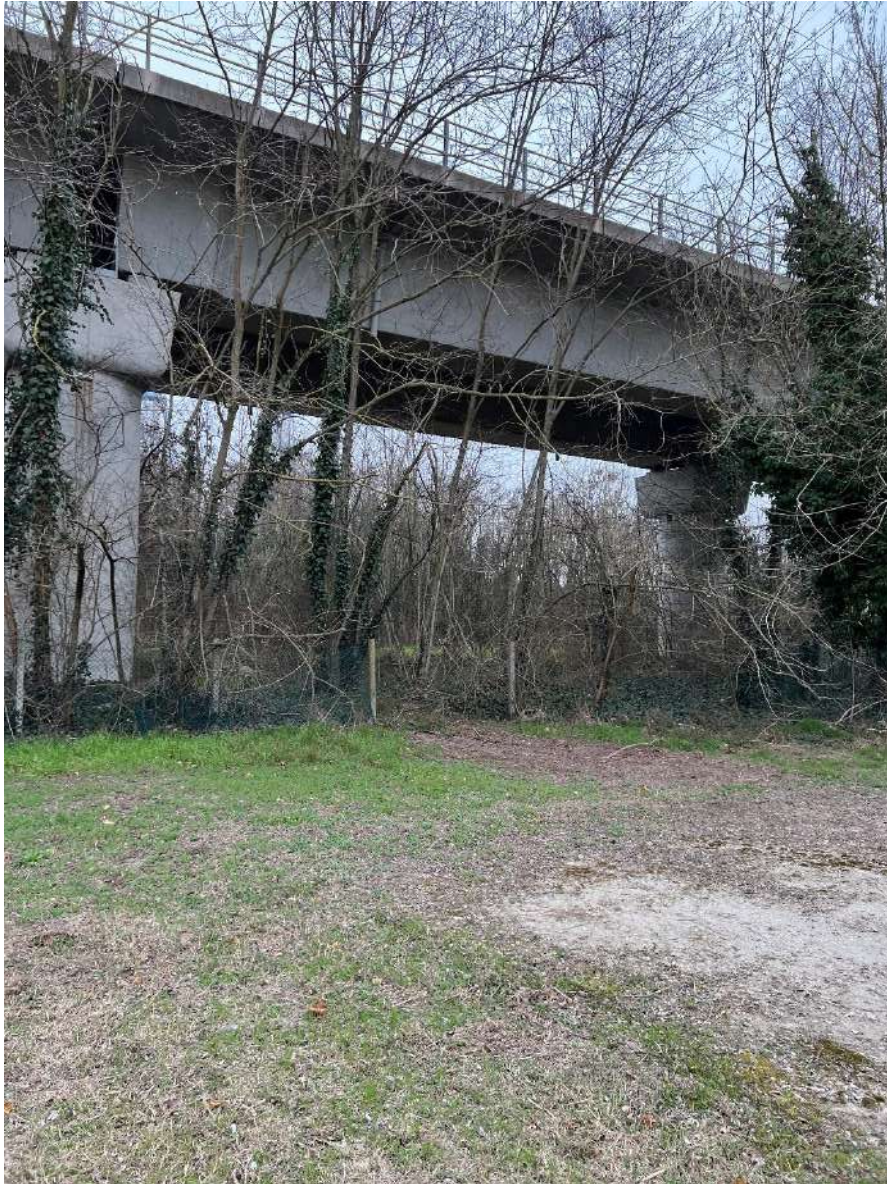
Figura 9: Recinzione sotto il tratto ferroviario
