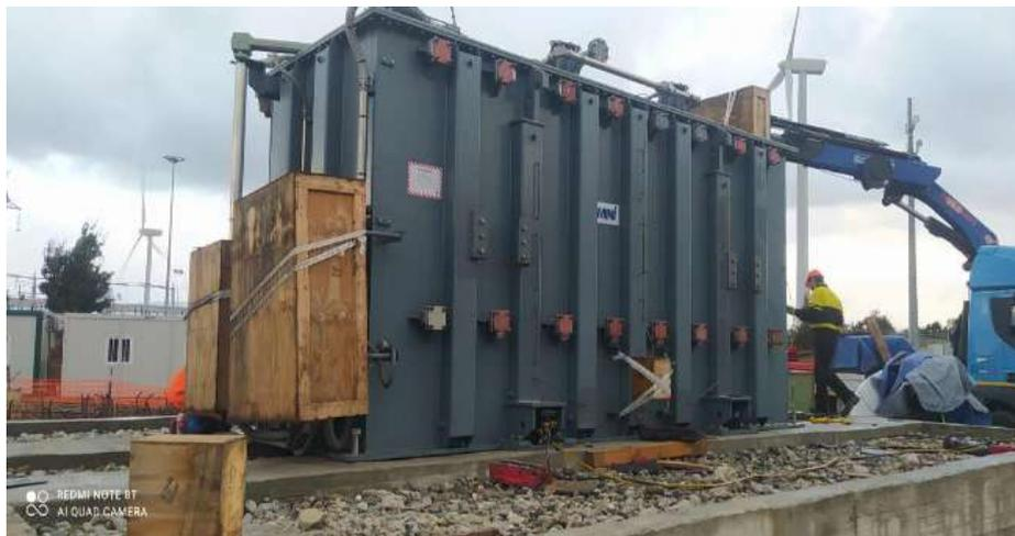
Foto 3 – Installazione trasformatore MT-AT
