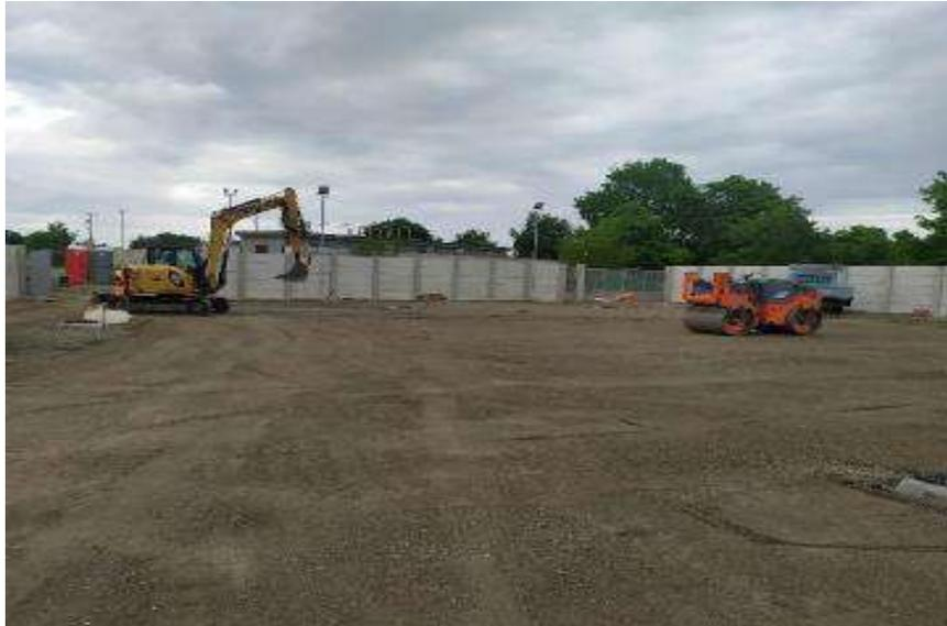
*Foto 1 – Pavimentazione in corso – posa misto*
