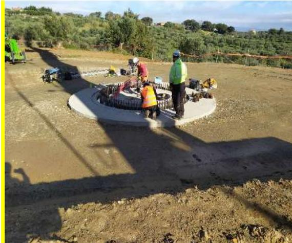
*Foto 2 – Predisposizione per montaggio WTG*
