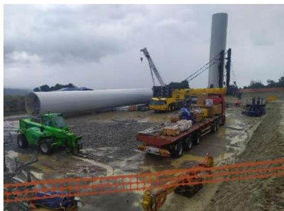
*Foto 2 - Installazione aerogeneratore in corso*
