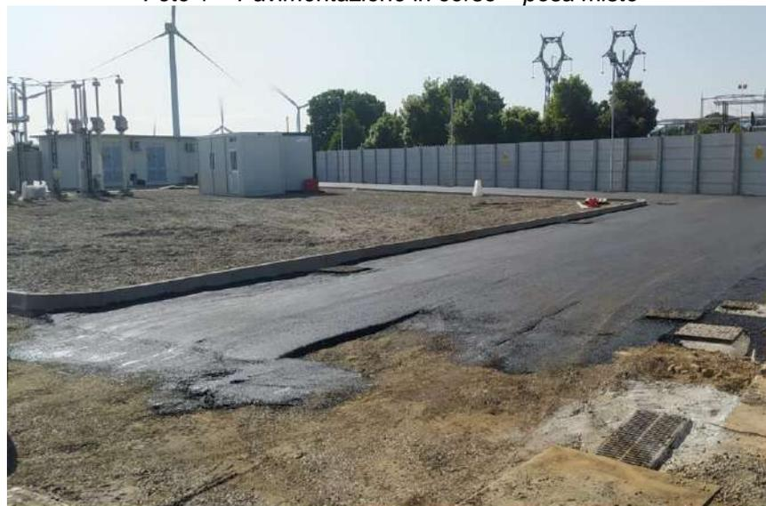
*Foto 2 – Pavimentazione in corso – posa binder*
