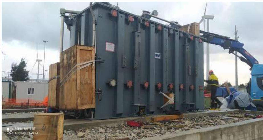
*Foto 3 – Installazione trasformatore MT-AT*
