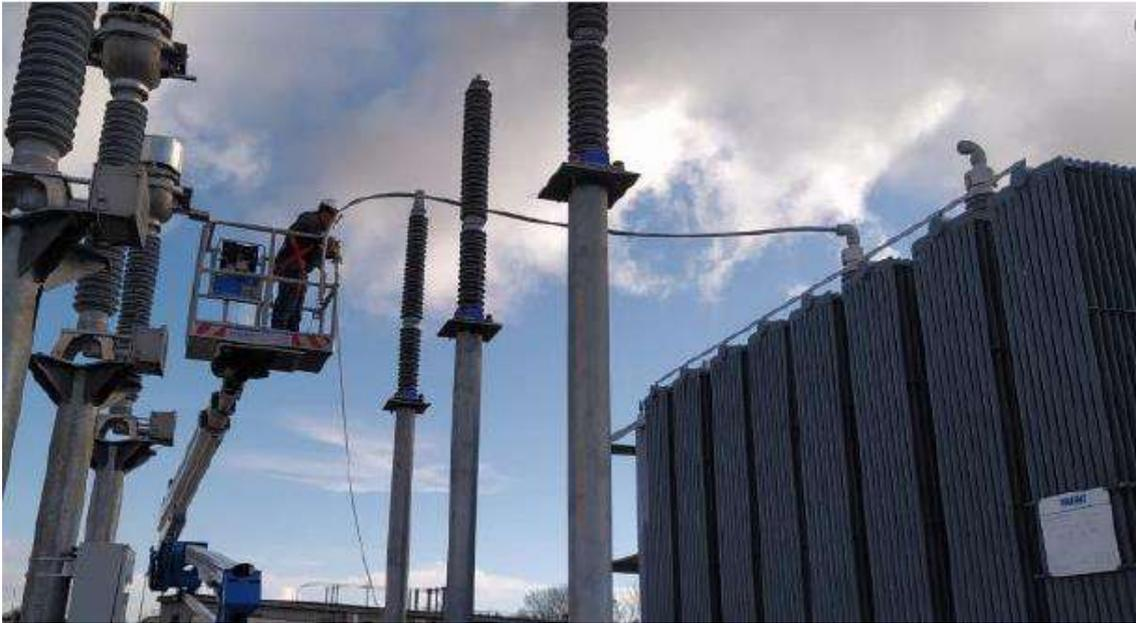
*Foto 2 – Installazione conduttore alta tensione*
