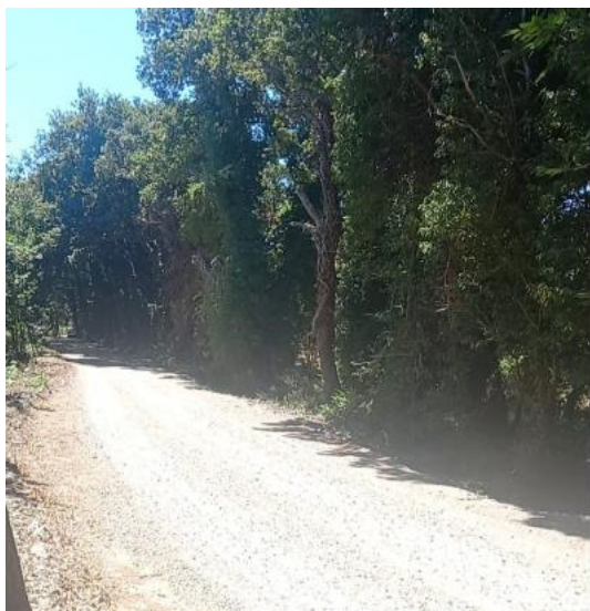
Strada di accesso WTG A02 (allargamento)
