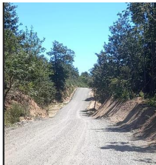
Strada di accesso WTG A03 (allargamento)
