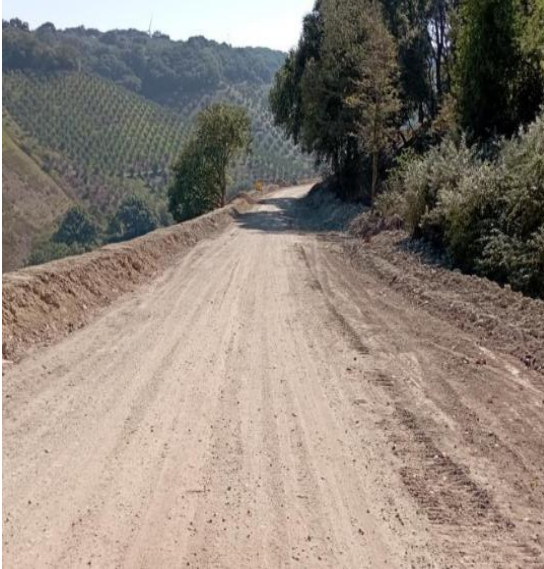
Strada di accesso WTG A26
