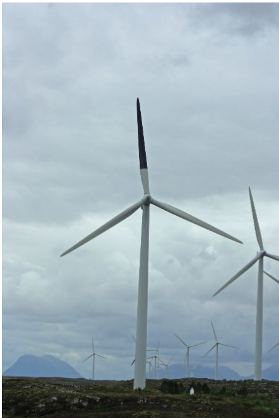
Turbina eolice con pala colorata di nero nell'impianto di Smøla – Norvegia (fonte: May et al., 2020).
