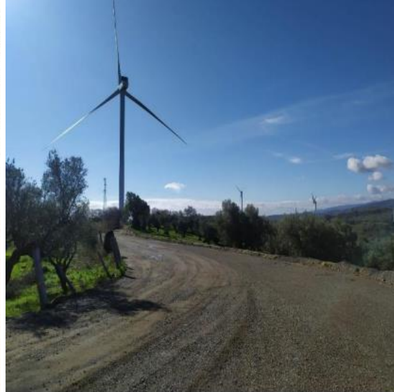
Strada di accesso WTG A32
