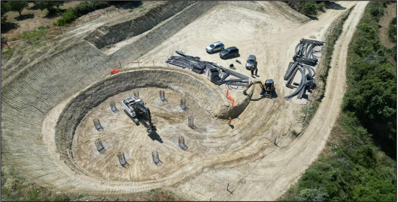
Figura 3.2.A- Esempio di gestione dei mezzi di cantiere
