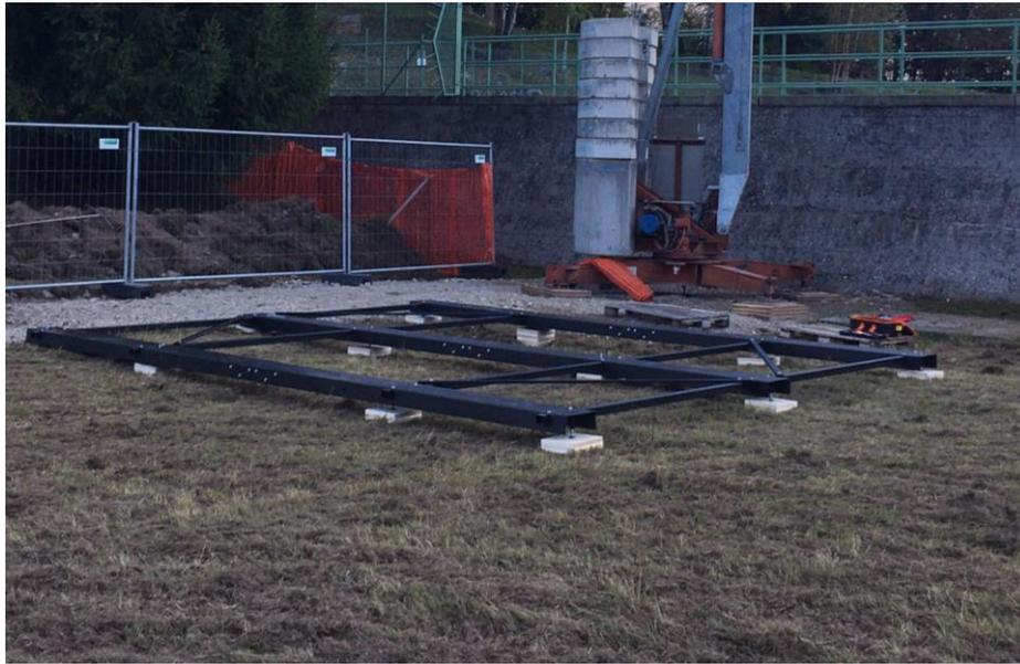
**Dima di montaggio delle zattere**
