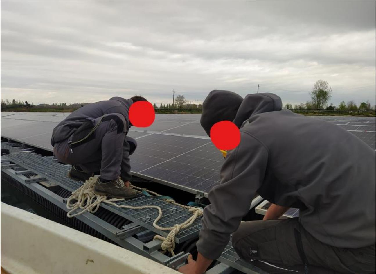
**Esempio di operatori durante il fissaggio delle zattere alla porzione di impianto esistente**
