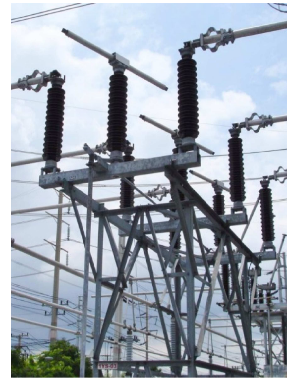
3 SEZIONATORE CON LAME DI TERRA
