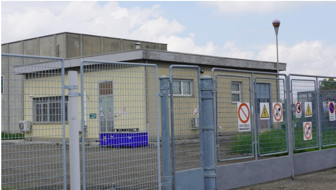
Figura 68 Cabina Primaria Esistente
