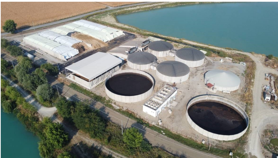
Figura 10. Impianto per la produzione di biogas da FER sito tra i due bacini lacuali interessati dal progetto. Fonte: rilievo fotografico SAPR ENVIarea (ottobre 2021)
