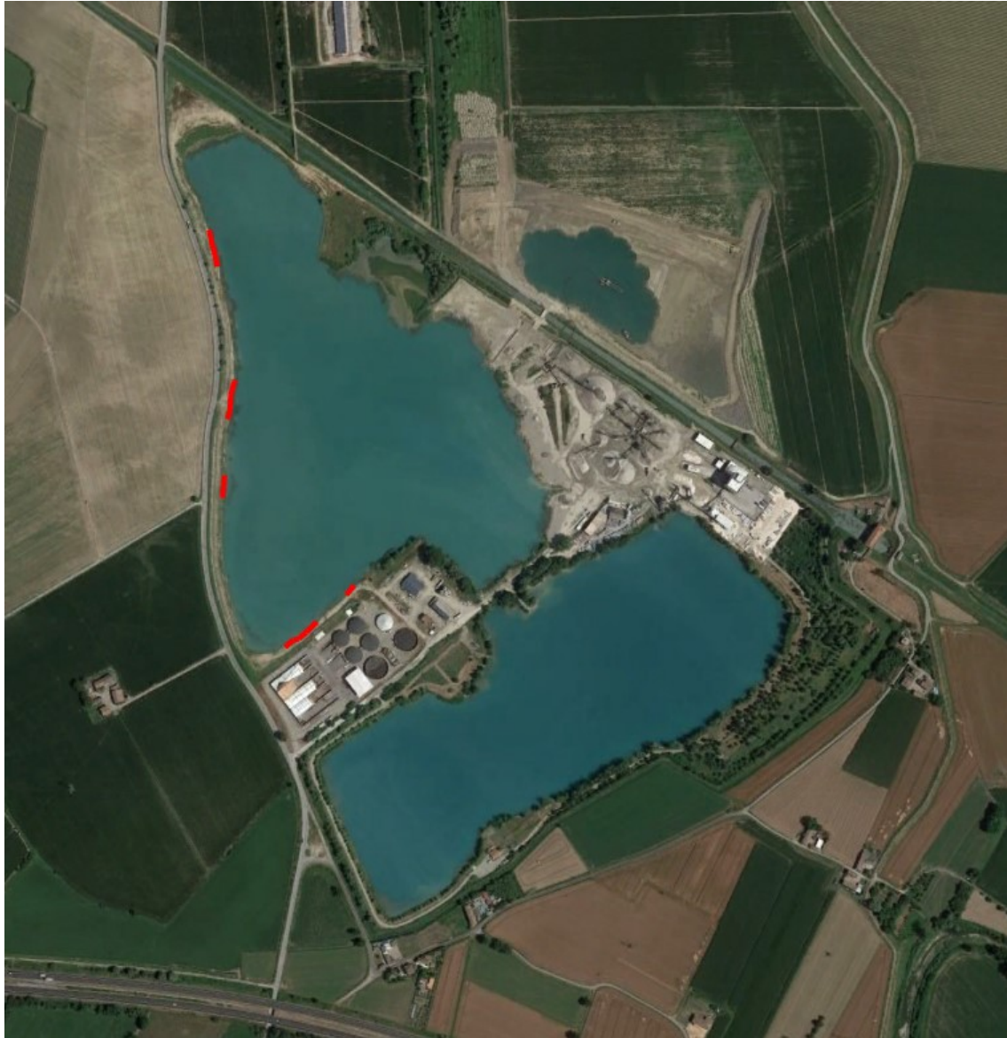
Figura 35. I bacini lacuali di Cave Podere Stanga e i tratti spondali ove si sono verificati locali dissesti spondali
