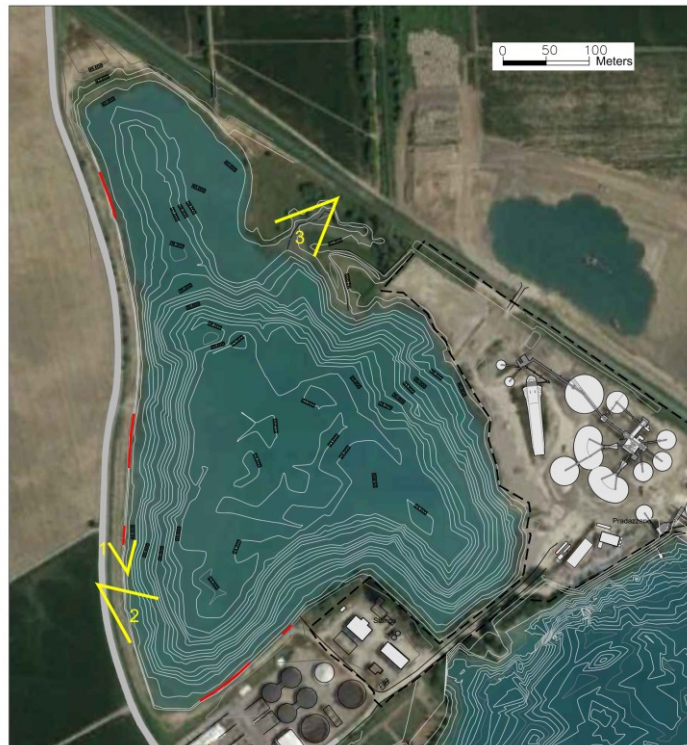
Figura 29. Bacino lacuale nord di Cave Podere Stanga e documentazione fotografica dissesti spondali rilevati
