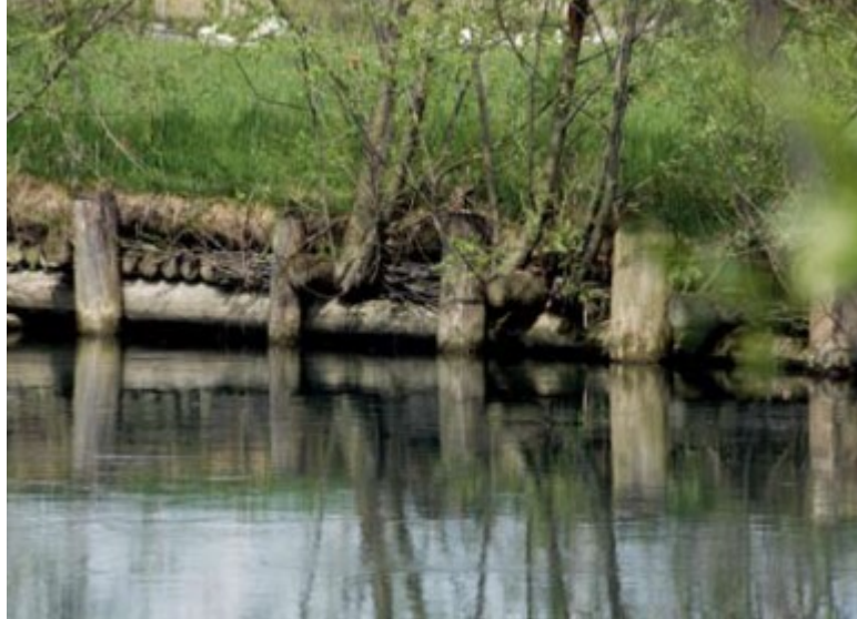
Figura 41. Esempio di palificata viva spondale in ambito lacuale a qualche anno dalla sua realizzazione. Fonte: Regione Lazio, AIPIN, 2000. Quaderni di cantiere del Manuale regionale dell'ingegneria naturalistica
