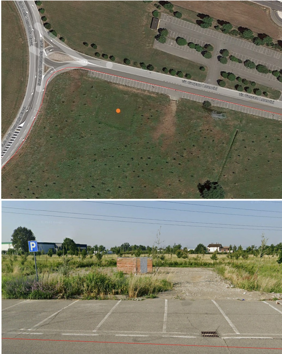
Figura 10. Il cavidotto interrato (linea rossa) lungo Via Gaspare Lorenzi e l'ubicazione del pozzo PCP49 (punto arancio). Sotto, in una ripresa da Google Street View si osserva la cantierizzazione con la tesa del pozzo appena realizzato (ripresa fotografica a terra del giugno 2023)
