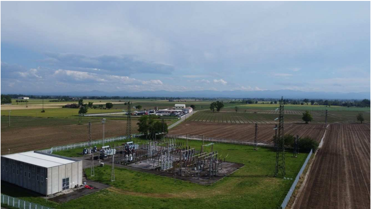
Figura 66 Cabina Primaria Esistente
