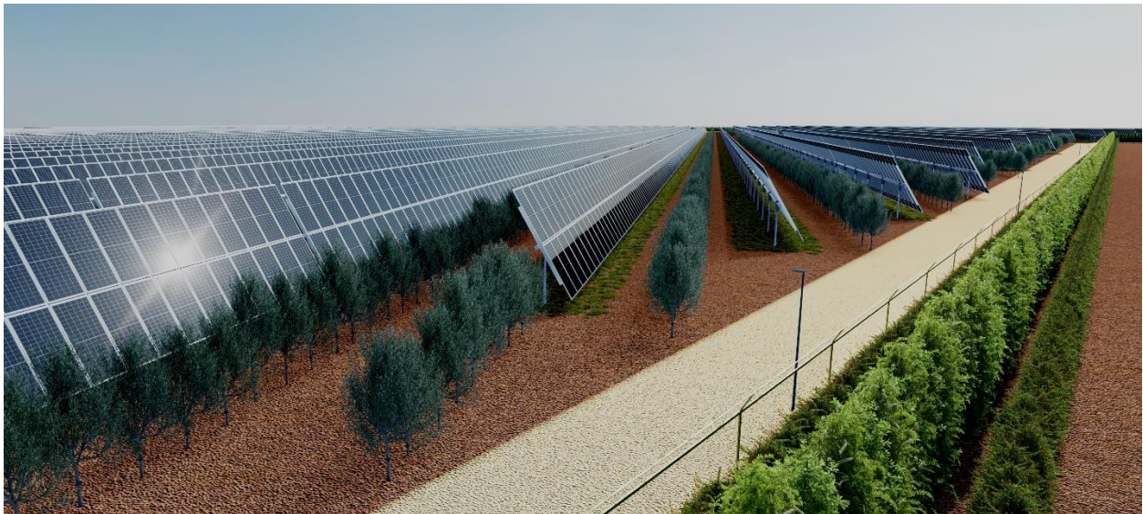
Figura 4 Rendering dell'impianto agrivoltaico con oliveto e essenze foraggere azoto fissatrici
