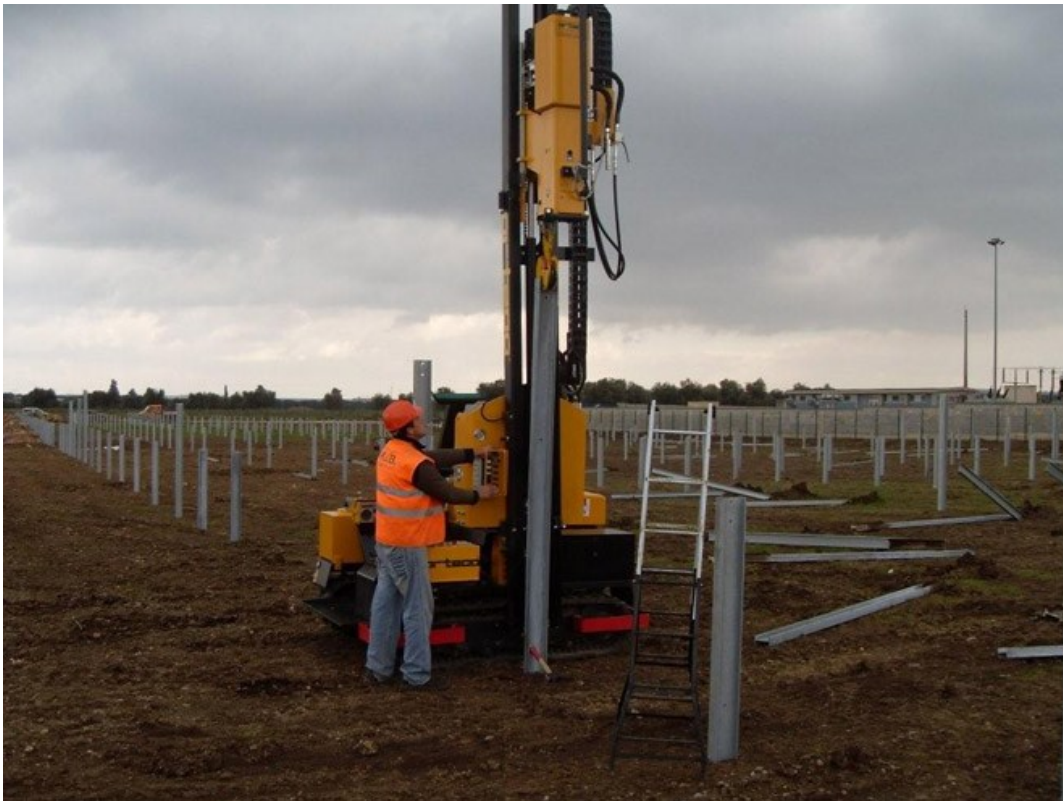
Figura 1 Operazione di rimozione dei pali infissi
