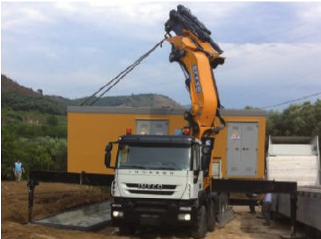
Figura 2 Operazione di rimozione delle cabine prefabbricate
