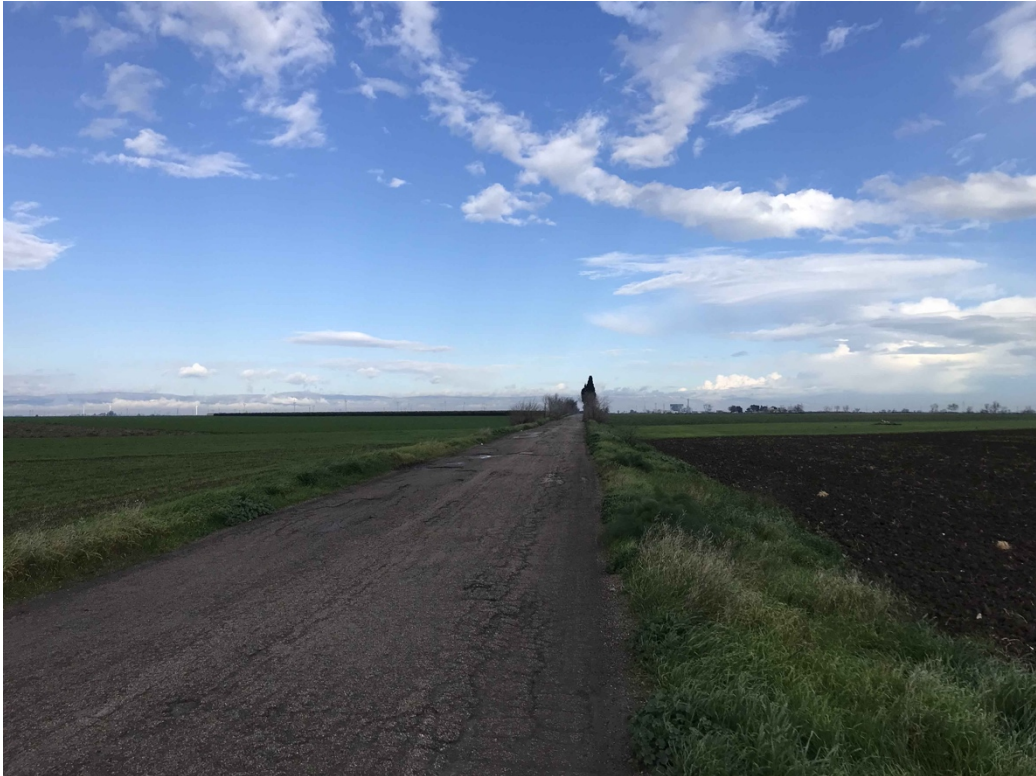
Figura 13. Cavidotto, Località La Pescia vista da Sud.
