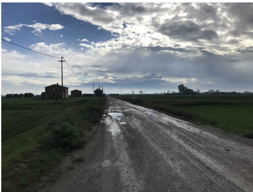
Figura 16. Cavidotto, Località La Pescia vista da Nord.
