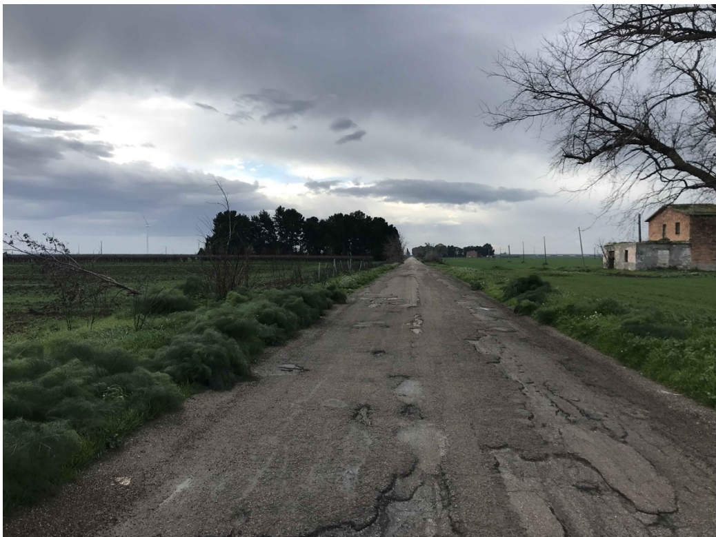
Figura 12. Cavidotto, Località Bonassisi vista da Nord.
