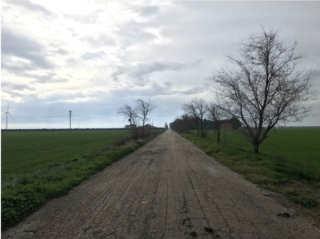
Figura 11. Cavidotto, Località Bonassisi vista da Sud.
