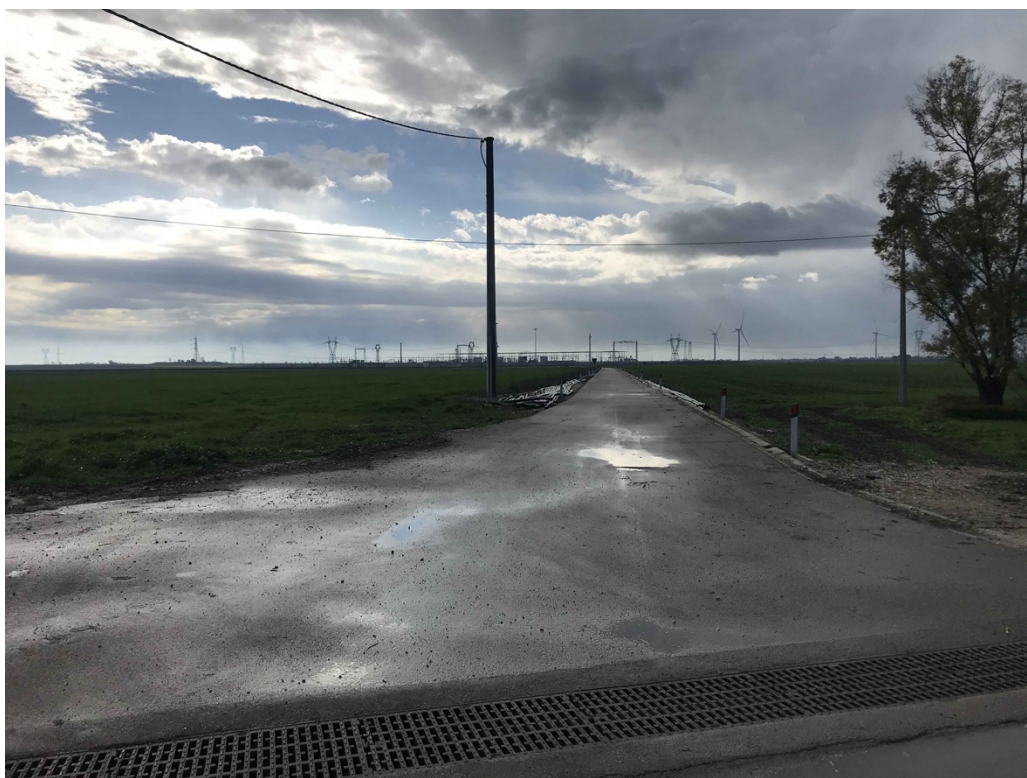
Figura 20. Cavidotto, Località Macchia Rotonda vista da Nord.
