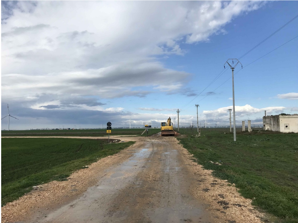
Figura 17. Cavidotto, Località La Pescia vista da Sud.
