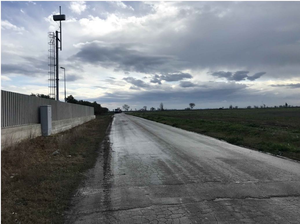
Figura 14. Cavidotto, Località La Pescia vista da Nord.
