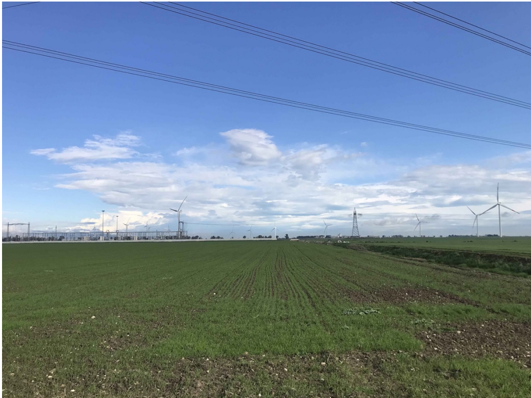
Figura 18. Cavidotto e SSE, Località Macchia Rotonda vista da Ovest.
