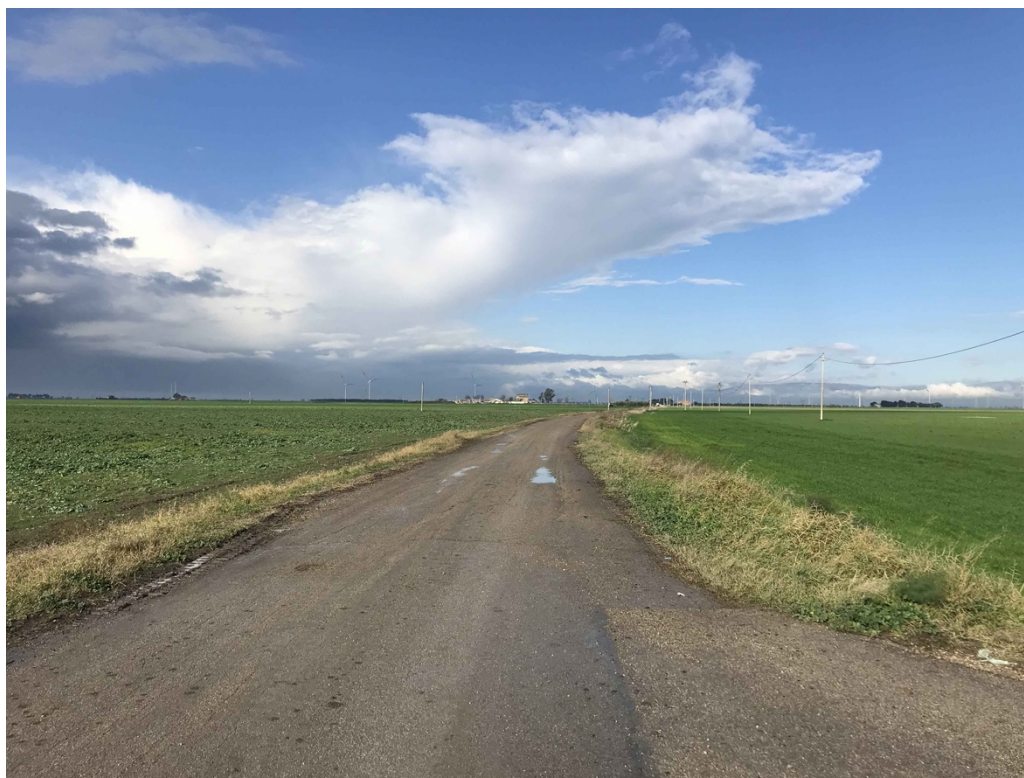
Figura 15. Cavidotto, Località La Pescia vista da Sud.
