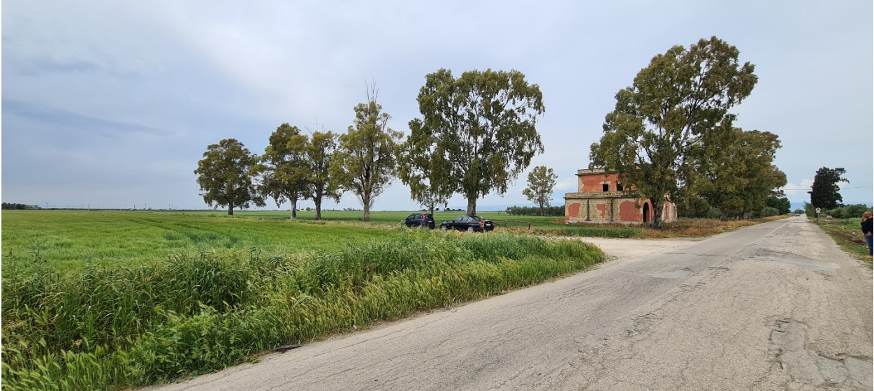
Figura 1 Foto °1 Area oggetto di intervento
