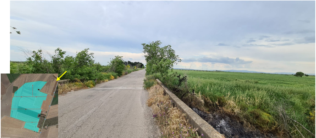
Figura 6 Foto °6 Area oggetto di intervento
