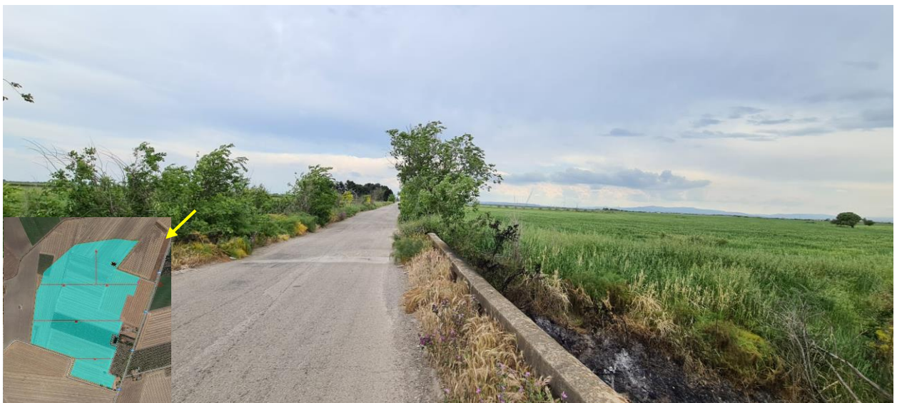
Figura 19 Foto °6 Area oggetto di intervento
