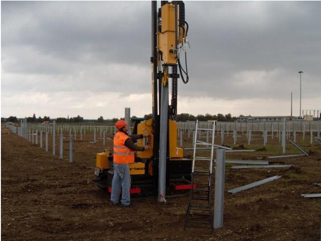
Figura 55 Operazione di rimozione dei pali infissi
