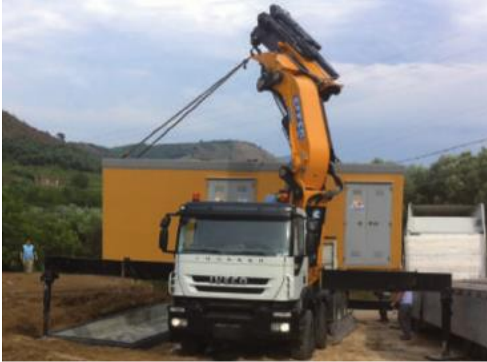
Figura 56 Operazione di rimozione delle cabine prefabbricate
