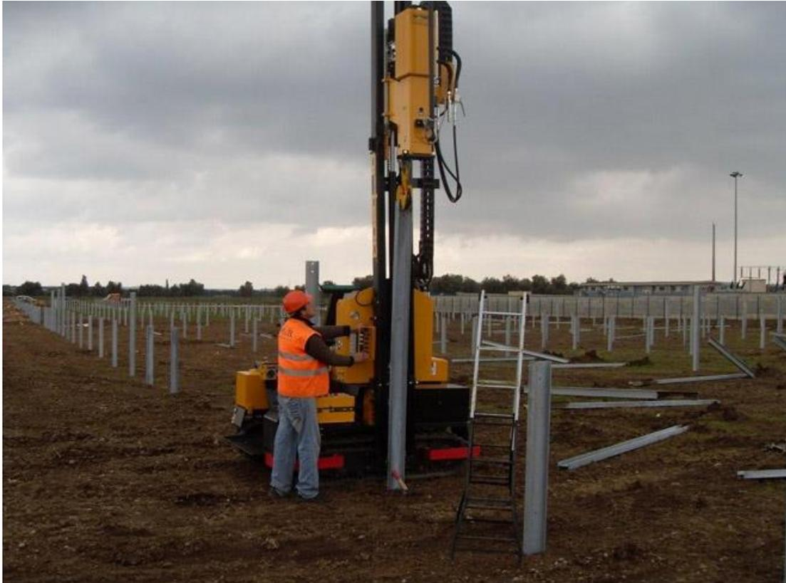
*Figura 17 Operazione di rimozione dei pali infissi*
