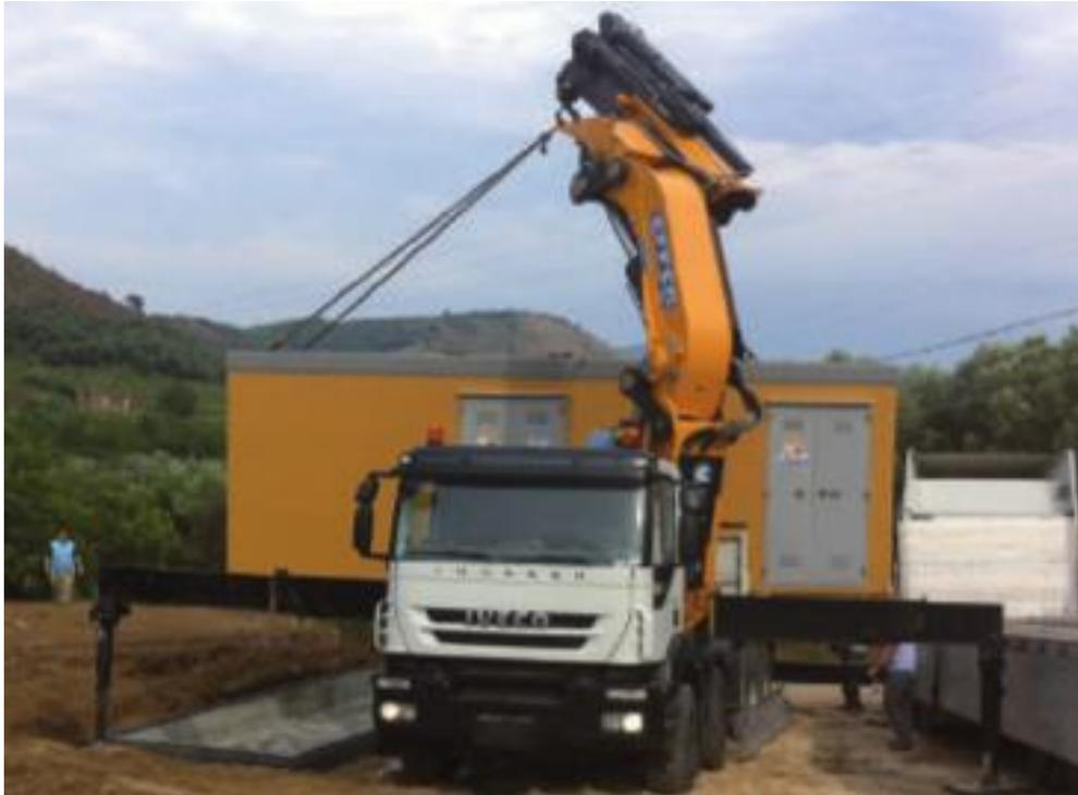
*Figura 18 Operazione di rimozione delle cabine prefabbricate*
