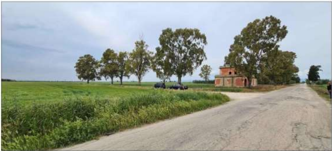
Figura 4-14: Vista dell'impianto - presa PVF01: ante-operam
