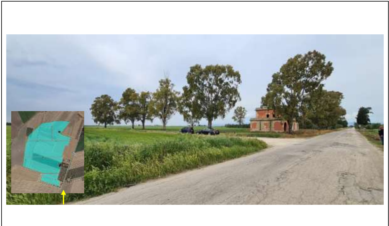
Figura 4-29: Veduta del sito di intervento
