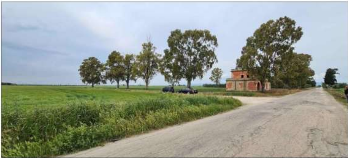
Figura 1-14: Vista dell'impianto - presa PVF01: ante-operam
